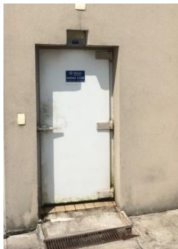
Figura 2.5.5.5-3 – Visão externa da Câmara Fria localizada na área não alfandegada anexa ao restaurante.
