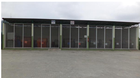
Figura 2.5.5.5-7 – Visão externa da Central de Resíduos 2 localizada na área alfandegada.
