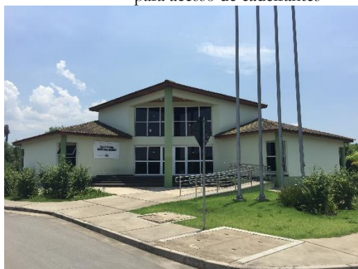
Figura 2.3.5.4-1 - Casa do Visitante com rampa para acesso de cadeirantes
