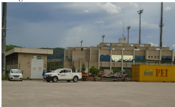
Figura 2.11.6.4.3-5 – Equipamentos de atendimento à emergência.
