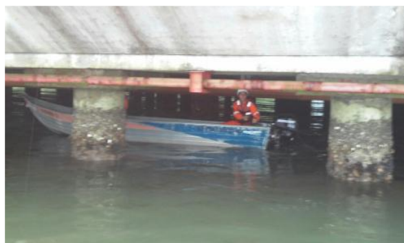
Figura 2.11.6.4.1-4 – Monitoramento embaixo do costado.
