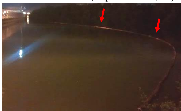
Figura 2.11.6.1-5 - Proteção da foz do Rio Saboó com barreiras de contenção (próxima ao Berço 03).
