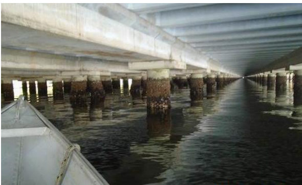
Figura 2.11.6.1-9 - Monitoramento embaixo do píer.
