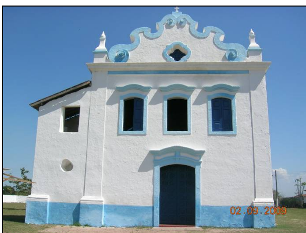
Figura 5.3.5-7: Igreja de Nossa Senhora das Neves.
