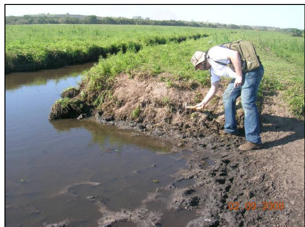
Figura 5.3.5-2: Barranco em canal de drenagem utilizado para observação de subsuperfície.
