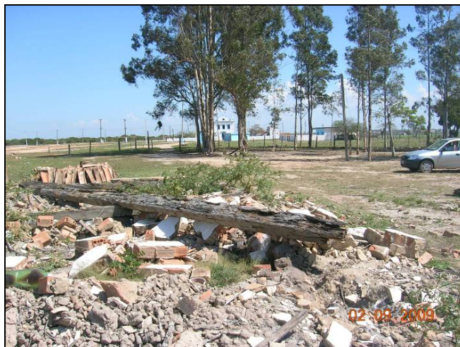
Figura 5.3.5-18: Ruínas de casa em frente à Igreja de Nossa Senhora das Neves.
