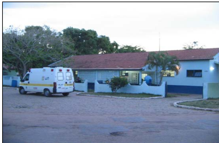
Figura 5.3.3.1-2: Unidade de Saúde de Barra de Itabapoana Foto: Cristian A. Senn (Out/09).
