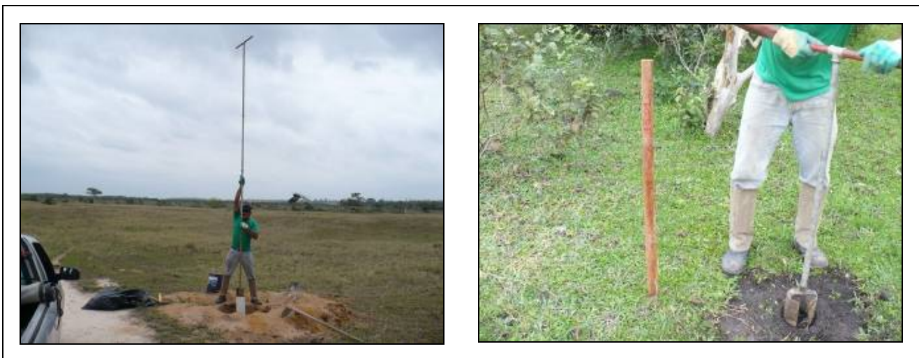
Figura 5.1.5.2-3: Imagens mostrando as operações de perfuração com trado manual.
