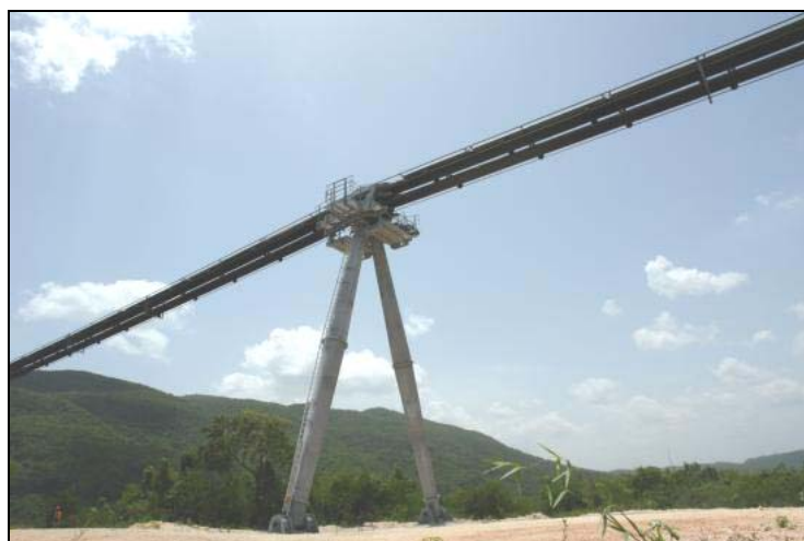
Figura 3.1.1.1-3: Coluna ou torre de sustentação típica de um transportador RopeCon.
