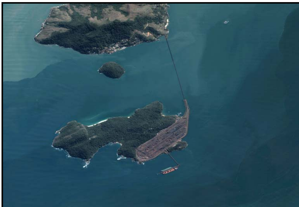
Figura 3.2.3-1: Vista aérea do Terminal da Ilha Guaíba.
