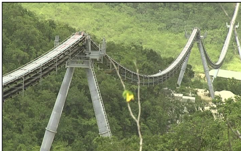
Figura 3.1.1.1-2: O transportador RopeCon pode vencer vãos muito maiores que os convencionais.
