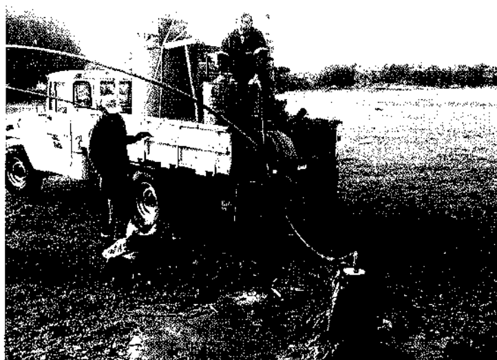
Figura 19: Lavagem, limpeza e desinfecção do Poço Tubular.
