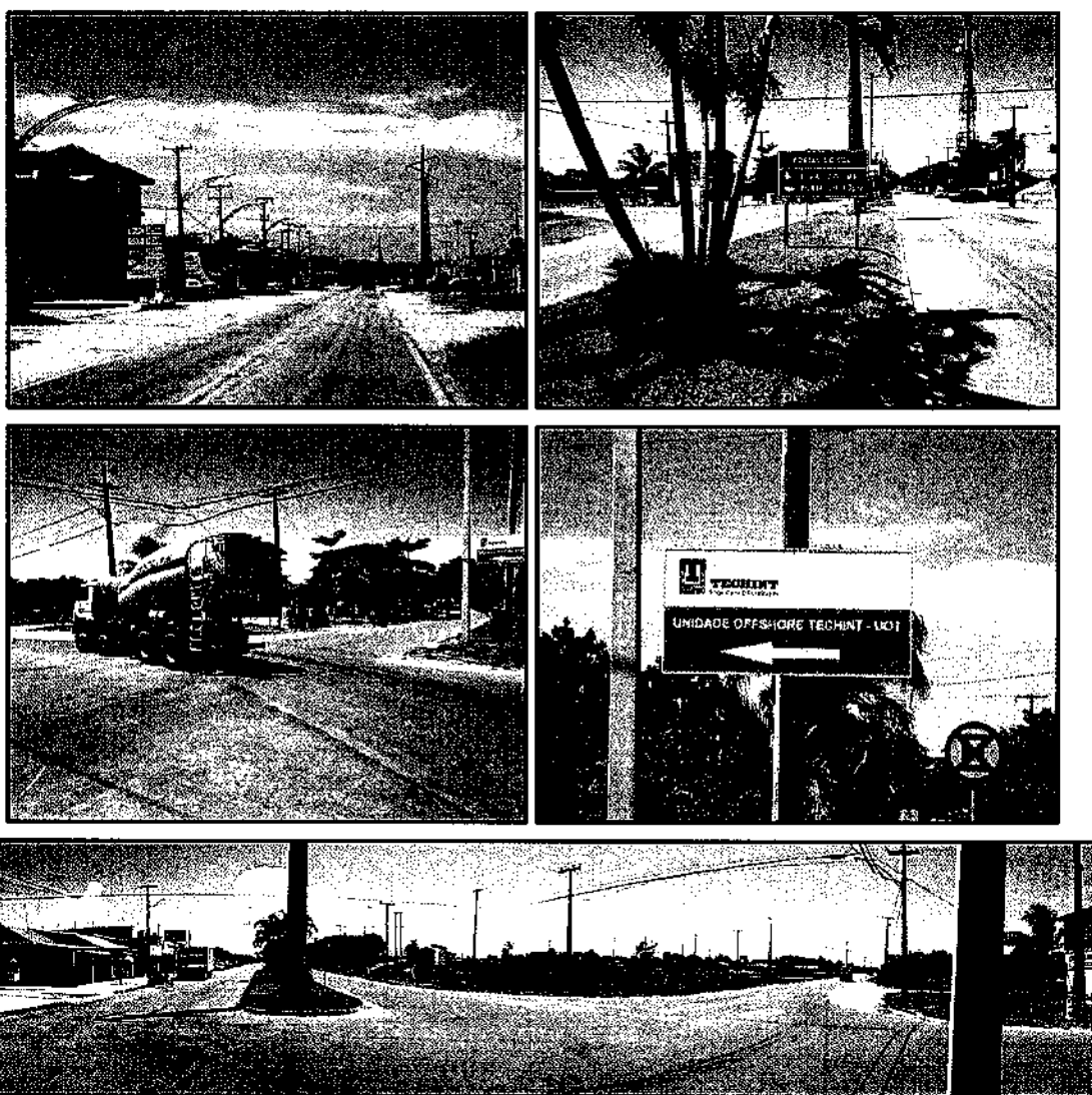
Figura 33 - Detalhes da condição atual de sinalização, iluminação e do pavimento da PR-412 nas imediações do balneário Pontal do Sul, incluindo registro de caminhão de concreto que circula entre a usina de concreto (PR-407) e o vizinho do TPPP, em obras.
