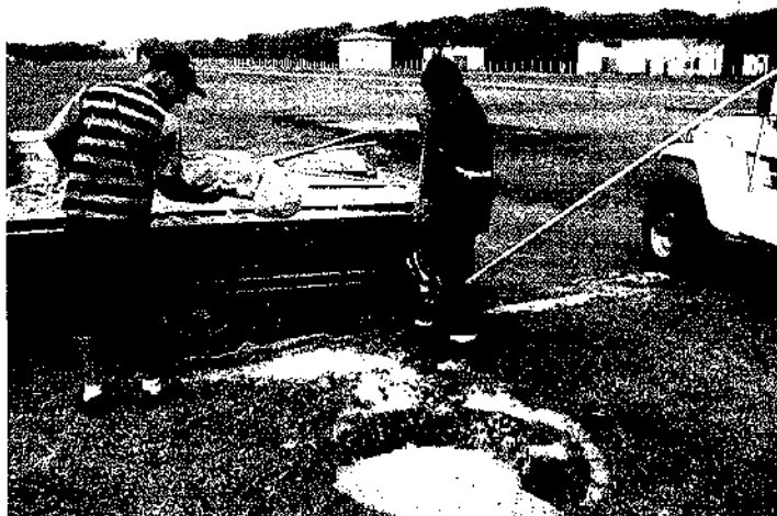
Figura 23: Preenchimento do Poço Boca Larga com areia lavada
