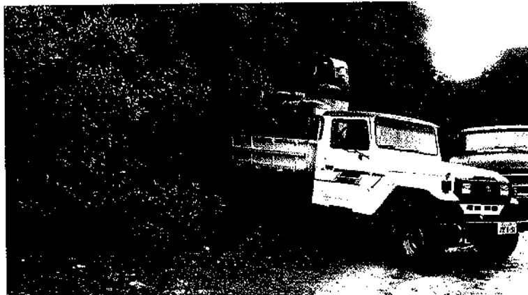
Figura 10: Equipe e equipamento no tamponamento do Poço PM-02
