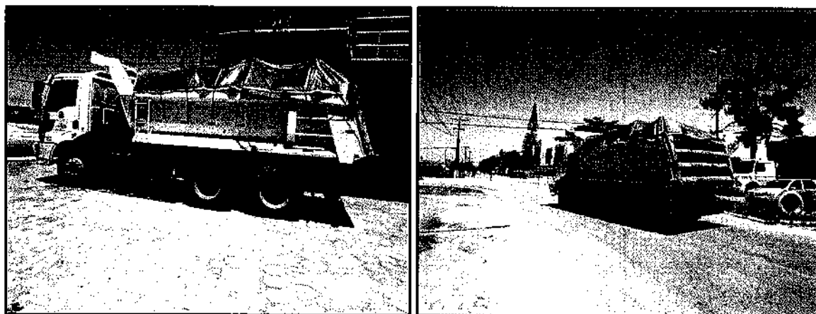
Figura 31 – Detalhes de caminhão carregado com matacões (enrocamento), enlonado, proveniente de jazida comercial da região e rumo à Techint, empresa vizinha do TPPP.
