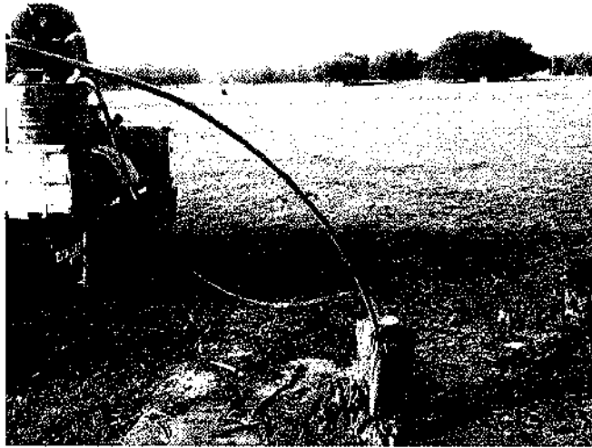
Figura 16: Lavagem, limpeza e desinfecção do Poço Tubular.
