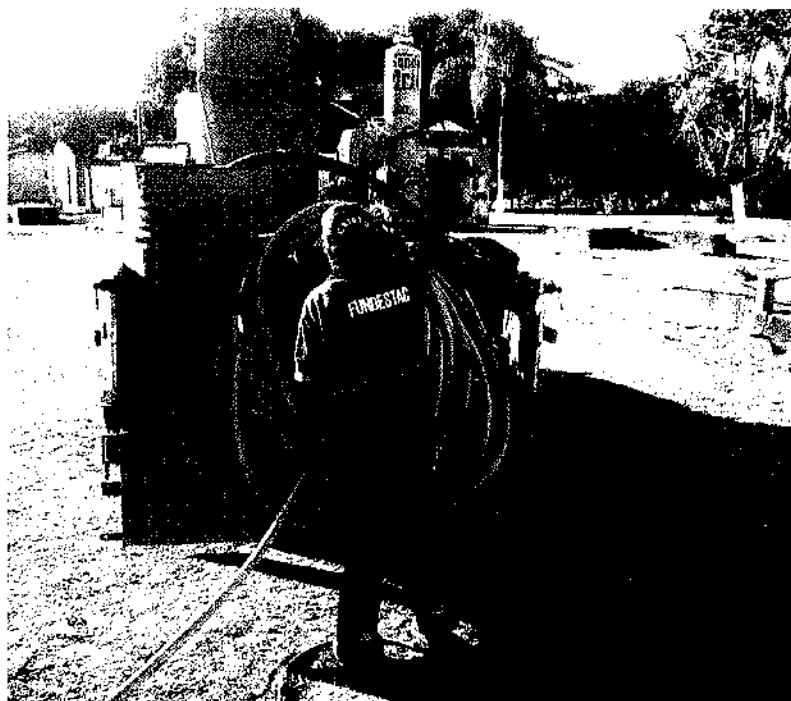
Figura 1: Equipe e equipamentos utilizados para o tamponamento dos poços
