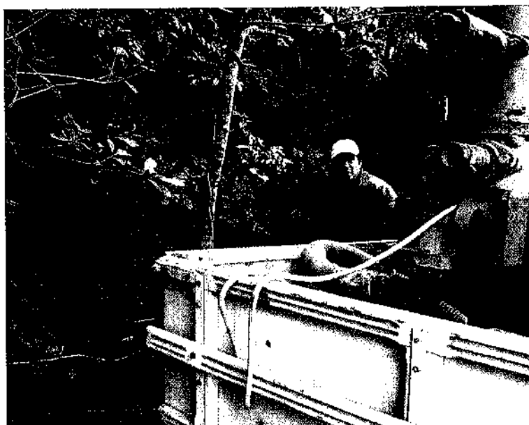
Figura 11: Equipe e equipamento no tamponamento do Poço PM-02
