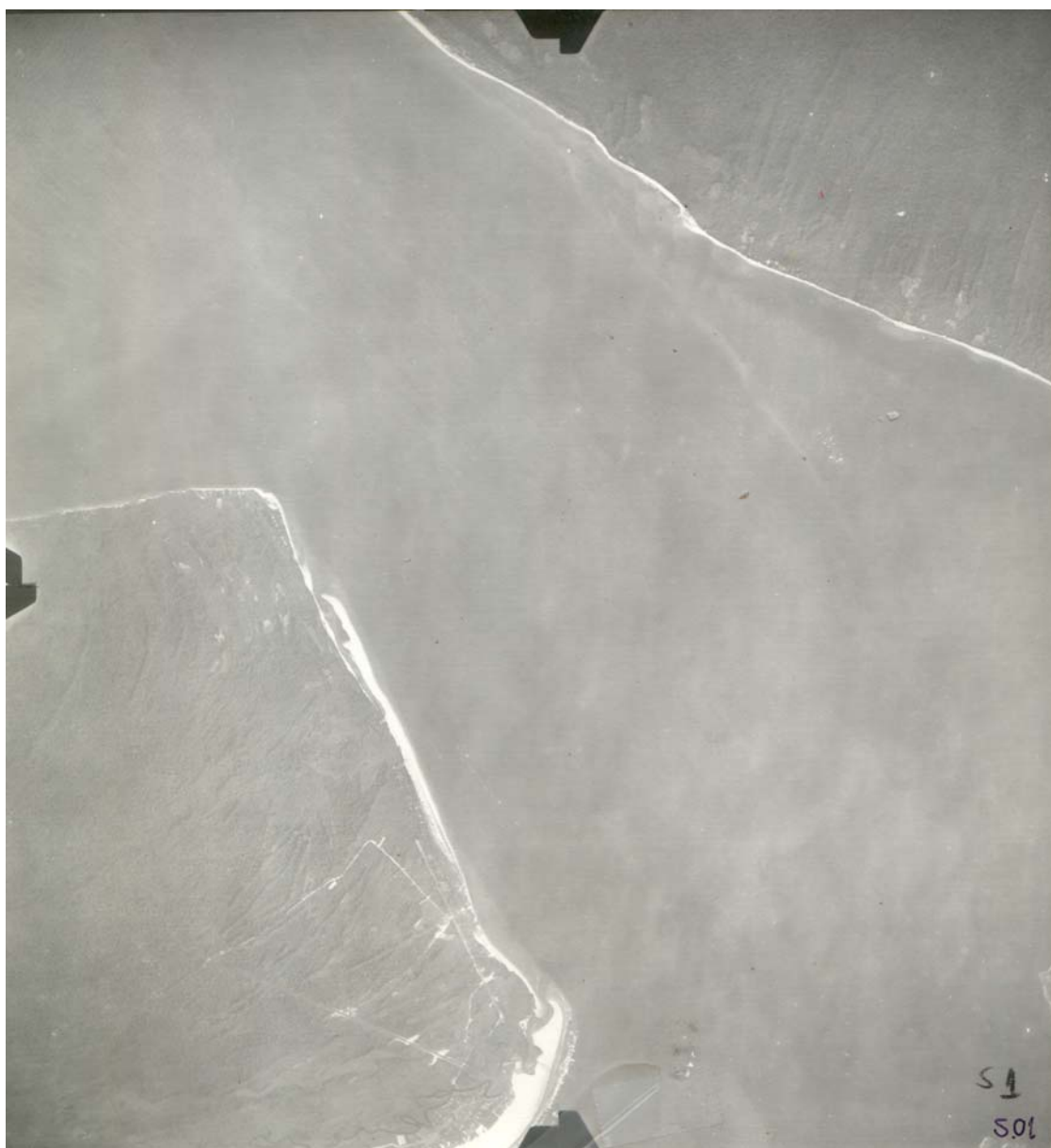
Figura 5.1.41: Fotografia aérea de 1953 da área de ponta do Poço.
