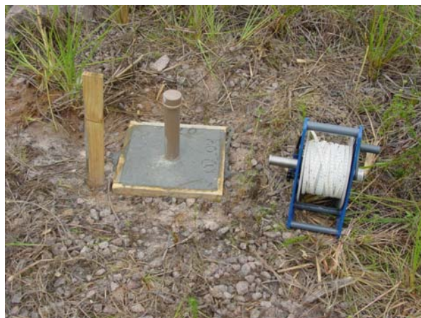
Figura 5.1.62: Parte externa do poço de monitoramento PM-7
