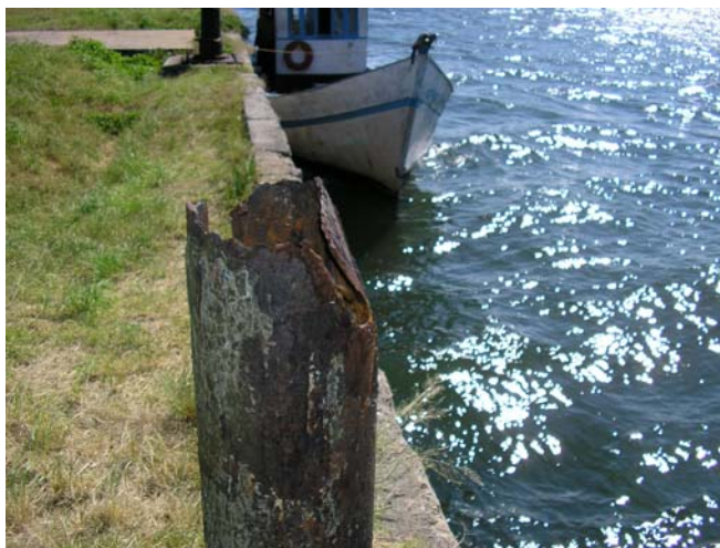
Figura 5.1.157: Movimentação de pequena embarcação no trapiche da área do TCPP.
