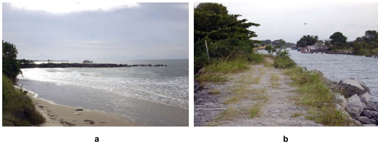
Figura 5.1.46: Fotografias do guia-corrente em rocha construído no anos 90 para evitar o assoreamento da foz do canal do DNOS. Vista de sul (a), vista desde o guia-corrente em direção ao canal do DNOS (b).
