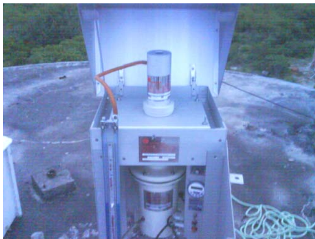
Figura 5.1.15: Hi-vol: estação utilizada no monitoramento de PTS com Kit de Calibração instalado.
