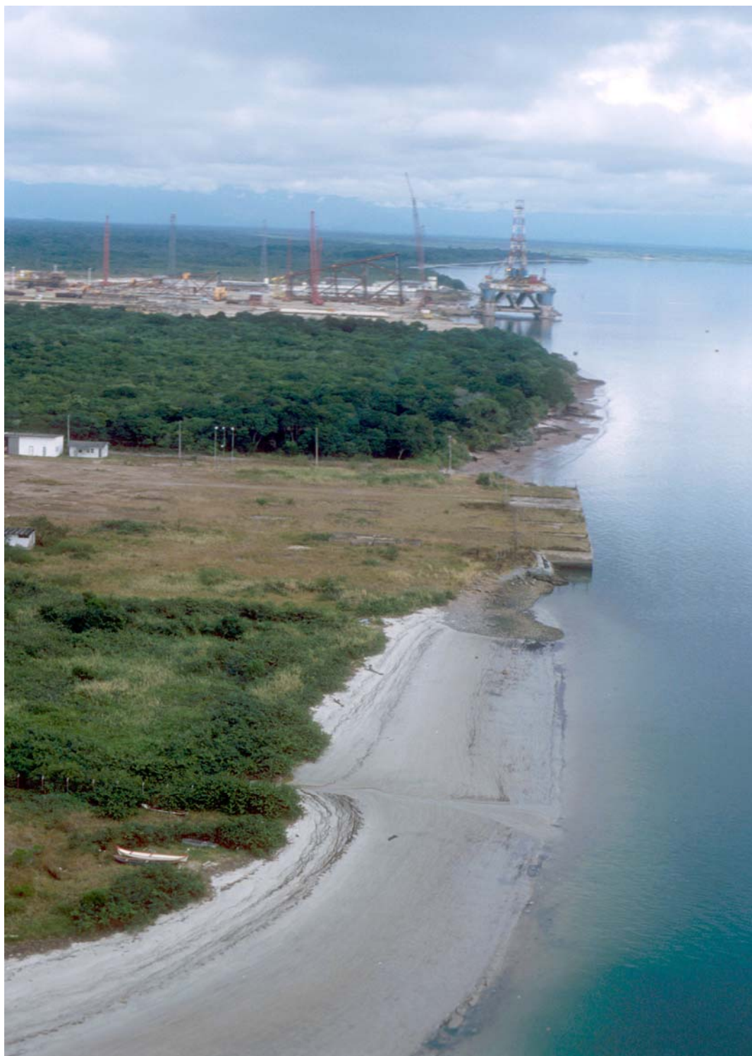
Figura 5.1.42: Fotografia aérea oblíqua de 1994 da área do empreendimento onde pode ser observado o cais construído em 1981 e 1982.
