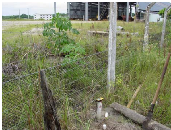
Figura 5.1.59: Vista do piezômetro PM-1, tendo ao fundo instalações da empresa Techint.
