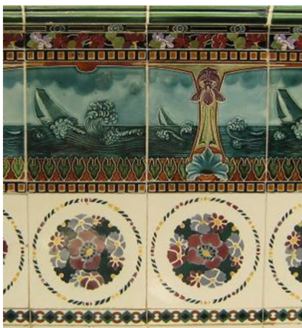
Detalhe da fachada interior da casa de Cultura Jorge Amado.
