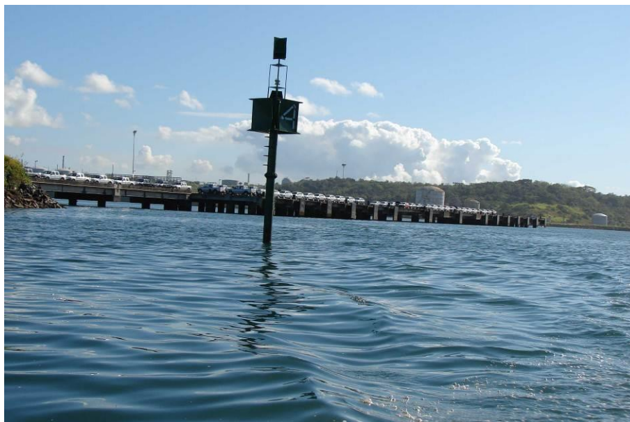
Foto 18. Vista da Estação 4, lado externo do terminal portuário Miguel de Oliveira.
