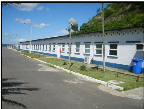
Fotografia 02- Prédio Administrativo (Prédio Administrativo - Sala de Reunião, Refeitório, Escritórios)
