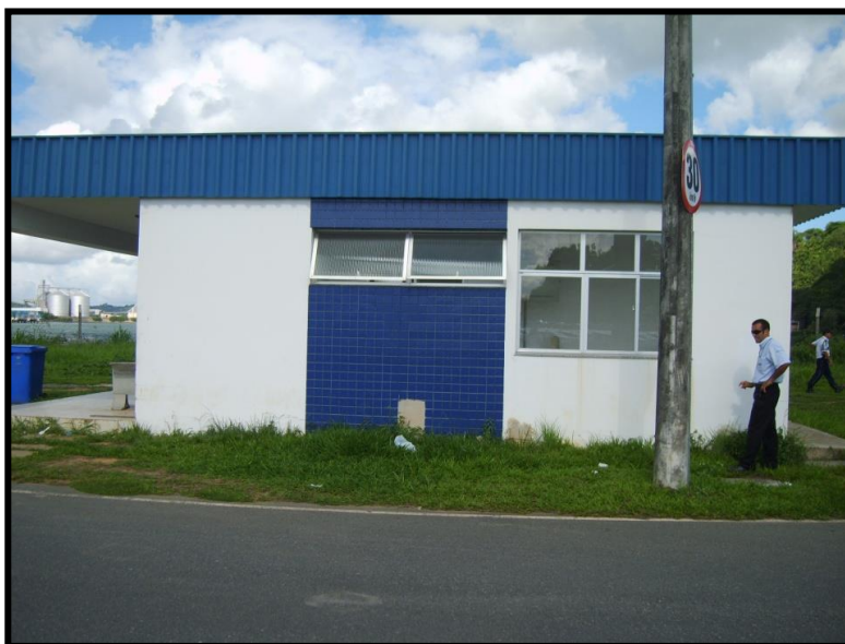
Fotografia 06 – Prédio de Apoio ao Cais
