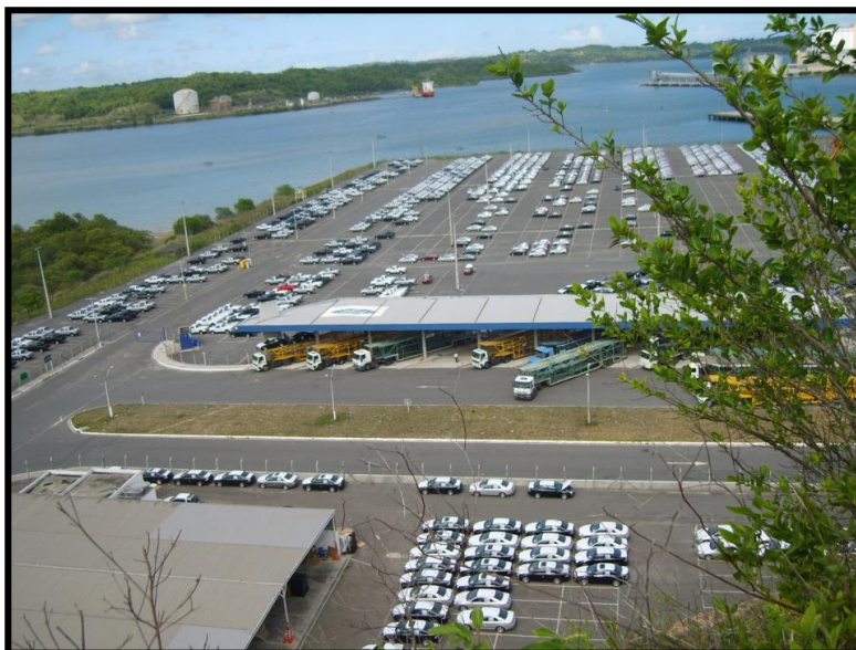
Fotografia 05 – Prédio de Carregamento e Descarregamento de Veículos
