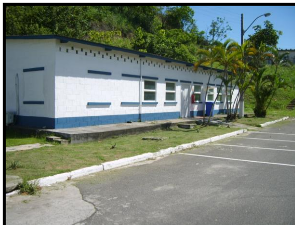
Fotografia 03- Prédio Administrativo (Prédio Administrativo: Sala das Câmeras de Vigilância e escritório da Receita Federal)
