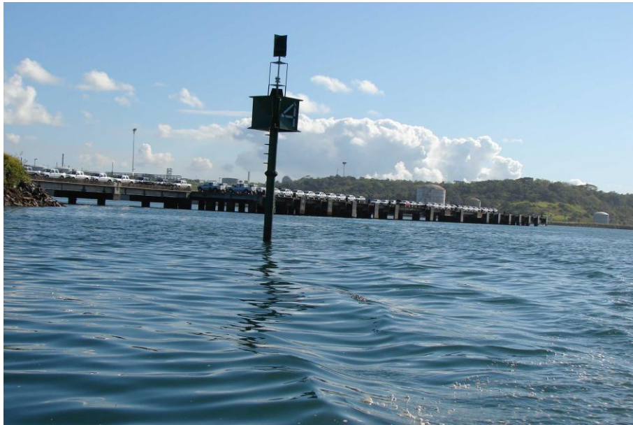
Foto 17. Vista da Estação 4, lado externo do terminal portuário Miguel de Oliveira.
