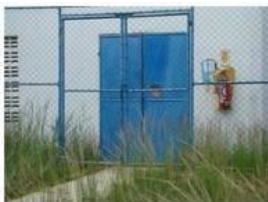
Figura 9.11.4-1 – Entrada da subestação.
