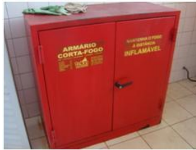
Figura 9.11.6-1 – Sala reservada no prédio de apoio na entrada do píer.
