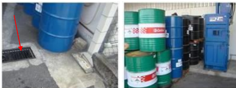
Figura 8.7.5-1 – Canaleta no alinhamento com o terreno externo na baía de resíduos.
