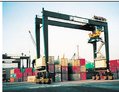
Figura 8: Equipamentos de movimentação de contêineres refrigerados (RTGs)
