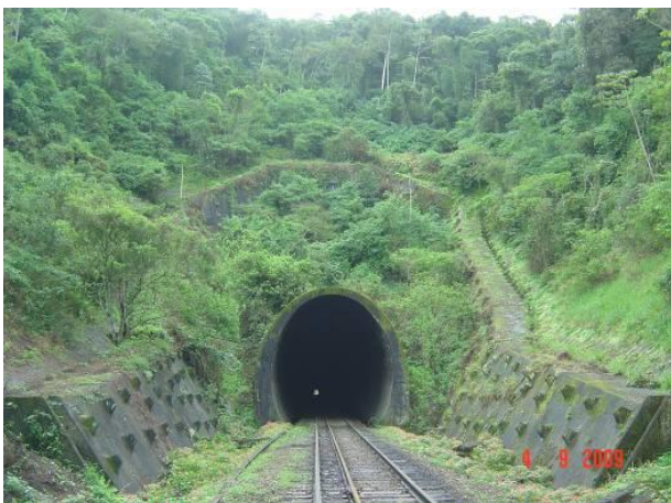
Figura 4.1.4.1.2 - 7: Vista do emboque do túnel do Ramal Ferroviário Conceiçãozinha e as obras de contenção na base da escarpa meridional da Serra do Quilombo. O túnel se encontra instalado na porção norte-nordeste da ADA transpondo o relevo acidentado da terminação da Serra.
