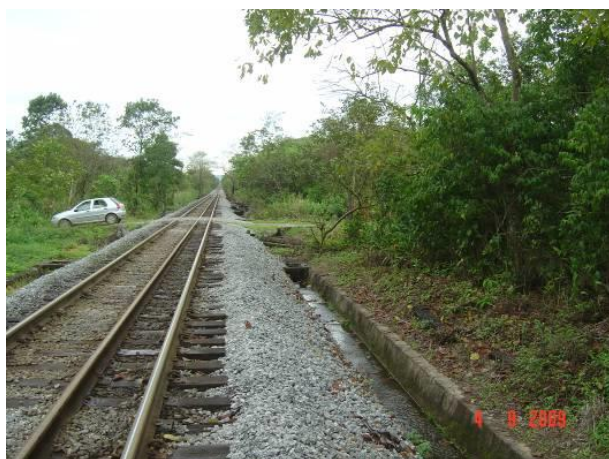
Figura 4.1.4.1.2 - 20: Vista geral da faixa de aterro que compreende o lastro de implantação do Ramal Ferroviário Conceiçãozinha instalado na porção leste-sudeste da ADA. Visada para sul-sudeste.
