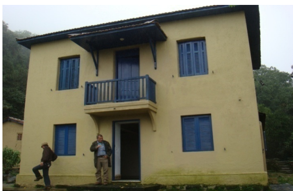
Figura 7.3.3.9 - 32: Casa de apoio existente dentro da propriedade.
