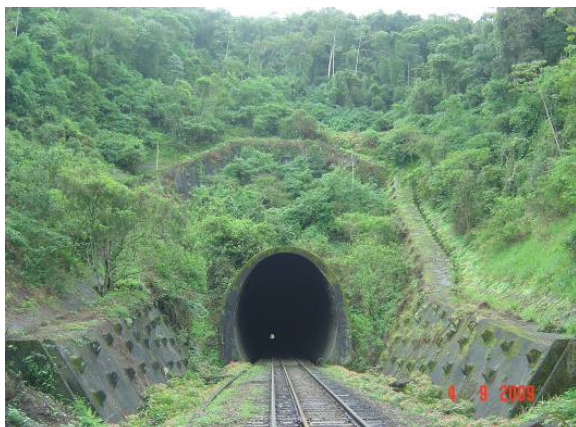
Figura 7.1.4.1.4 - 7: Vista do emboque do túnel do Ramal Ferroviário Conceiçãozinha e as obras de contenção na base da escarpa meridional da Serra do Quilombo. O túnel se encontra instalado na porção norte-nordeste da ADA transpondo o relevo acidentado da terminação da Serra.
