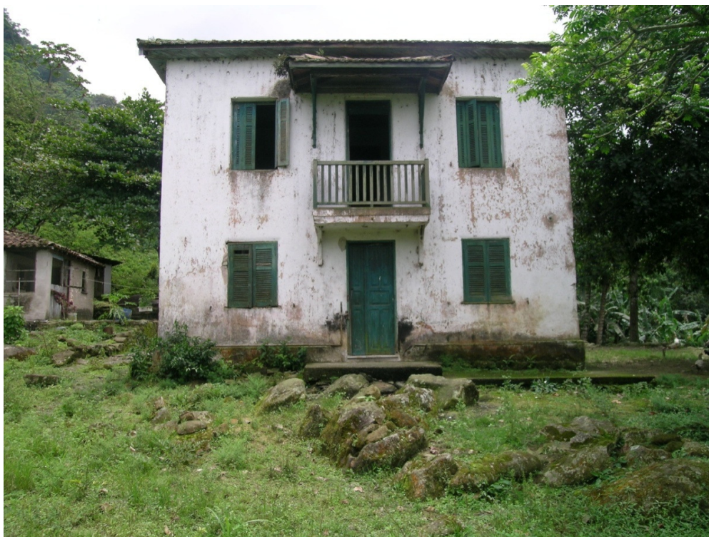
Figura 7.3.3.11 - 9: Vista Frontal da Residência do Sítio Santa Rita
