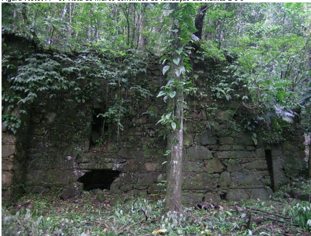
Figura 7.3.3.11 - 4: Vista da Ruína 4 (Forno) - Face Nordeste
