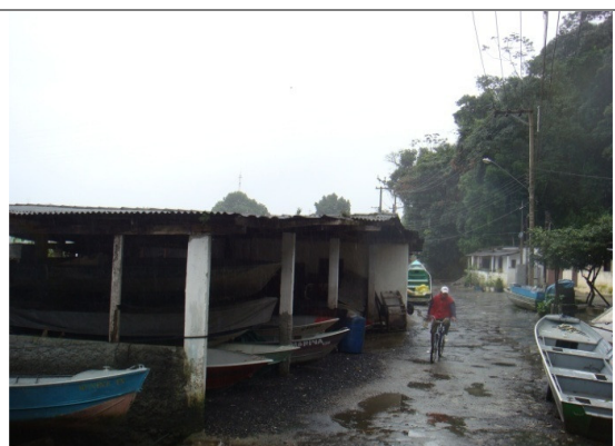
Figura 7.3.3.9 - 10: Estaleiro em Monte Cabrão
