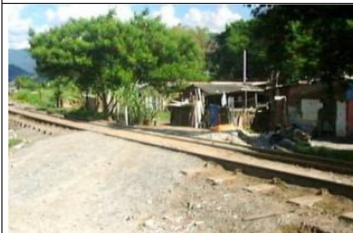
Figura 7.3.2.2 - 8: Cubatão - Interferências do meio urbano com a ferrovia
