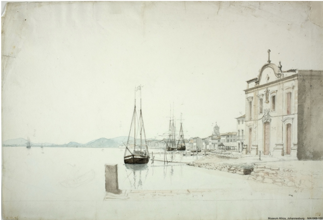
Figura 7.3.3.10 - 3 - “A Church and Ships, 11/10/1826”. William John Burchell. “Bela aguada vendo-se, no primeiro plano, a fachada da Igreja de Jesus, Maria e José protegida do mar por um pequeno cais de pedra seca; navios, alpendre, casario e torre da Igreja do Carmo. Demolida em 1902 por estar arruinada. Ficava, depois da construção das Docas, na Rua Antônio Prado”. Fonte: FERREZ, Gilberto (org.). O Brasil do Primeiro Reinado visto pelo botânico William John Burchel, 1825 / 1829 . Rio de Janeiro: Fundação João Moreira Salles / Fundação Nacional Pró-Memória, 1981, pp. 82-83.
