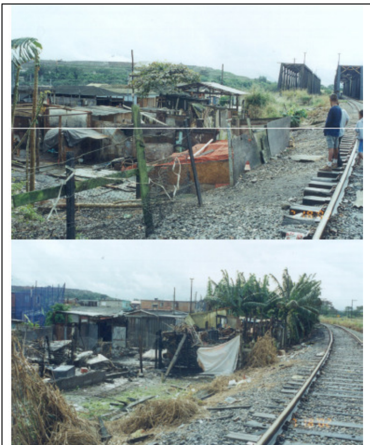
Figuras 7.3.2.2 - 6 e 7.3.2.2 - 7: Cubatão - Interferências do meio urbano com a ferrovia
