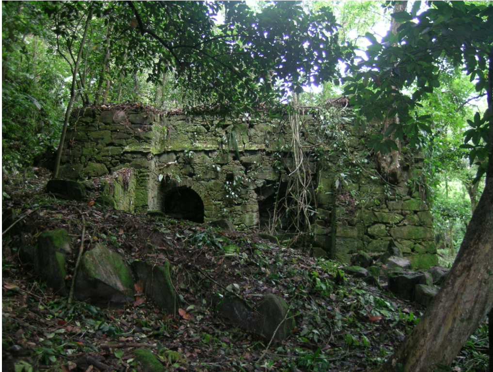
Figura 7.3.3.11 - 5: Vista da Ruína 4 (Forno) - Face Sudeste
