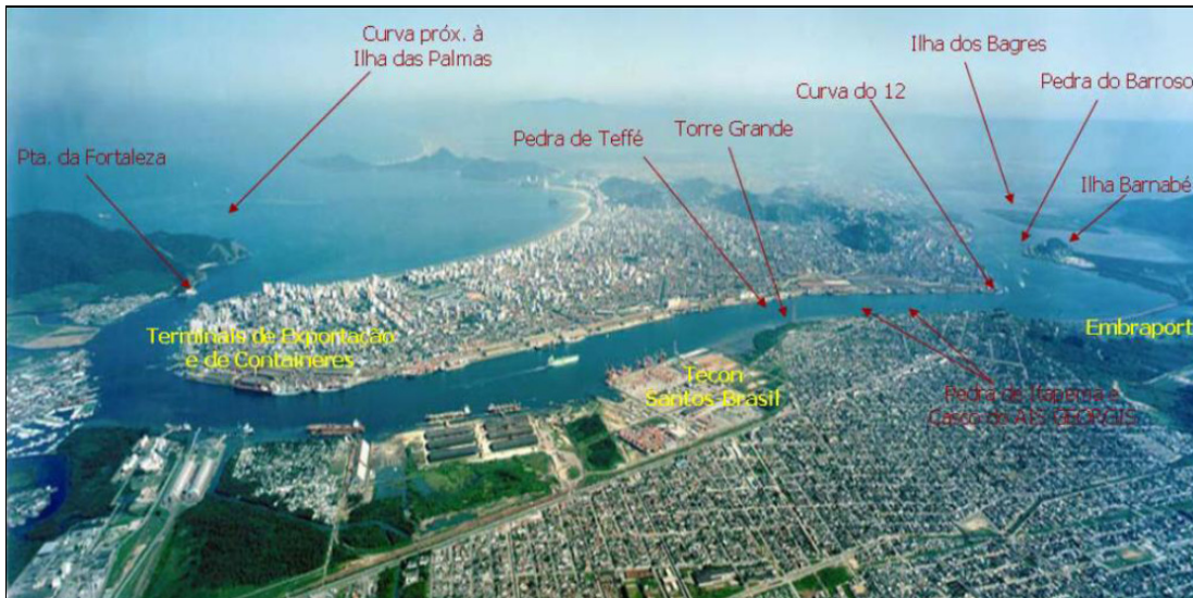
Figura 5.2.2.3 - 1: Vista aérea do Canal de Acesso ao Porto de Santos com destaque para trechos de restrição ao cruzamento de embarcações. Fonte: Codesp/INPH (2007)
