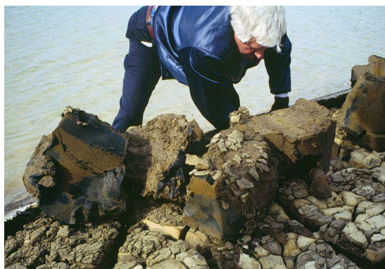
Figuras 2.3.1.1 - 9 e 2.3.1.1 - 10: Drenagem e consolidação do material sólido retido nos tubos
