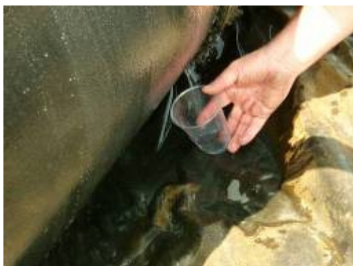
Figuras 2.3.1.1 - 9 e 2.3.1.1 - 10: Drenagem e consolidação do material sólido retido nos tubos
