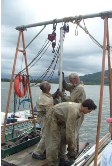
Figura 3: Retirada do cano de alumínio do suporte.
