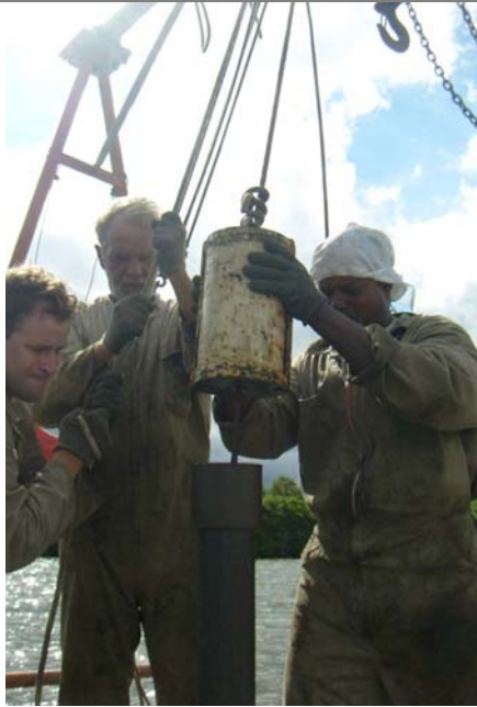
Figura 1: Bate-estaca utilizado para inserir o tubo de encamisamento no sedimento.
