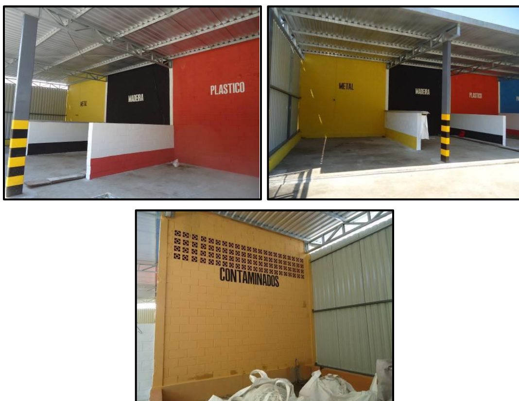
Figura 6 - Central de resíduos com baias para armazenamento interno temporário (recicláveis e resíduos contaminados).
