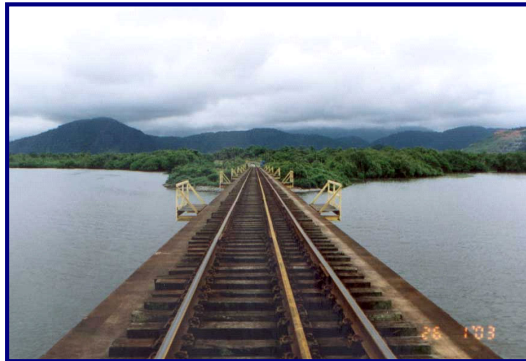
Foto 8.1- 12- Aterro de encontro da ponte ferroviária do ramal Conceiçãozinha na porção sul da área do empreendimento, com depósitos de baixios e, ao fundo, a planície de maré
