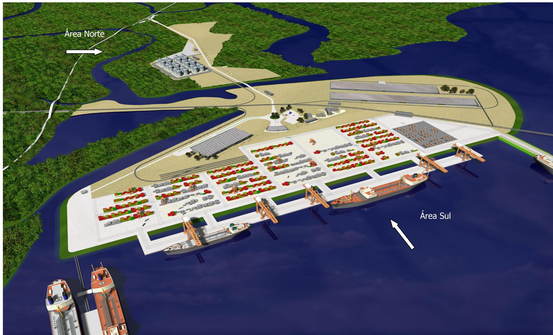
**A Alternativa 2** prevê a construção de um cais de atracação com 850 metros de extensão, com quatro berços permitindo a atracação simultânea de quatro navios. É prevista também a construção de um píer de atracação para navios graneleiros e um para navios de graneis líquidos, que permitirão a atracação simultânea de dois navios cada.
