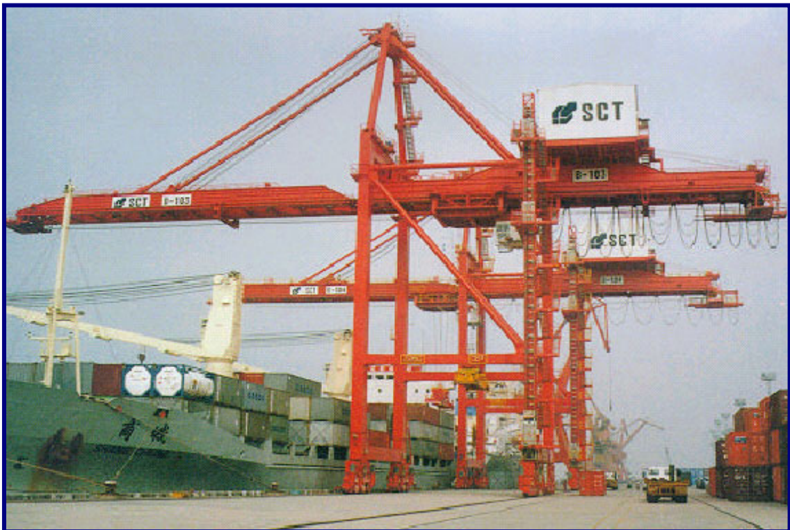
Foto 4.4 - 1 - Guindaste-Pórtico (“portêiner”) para Transferência de Contêineres entre Embarcação/Cais
