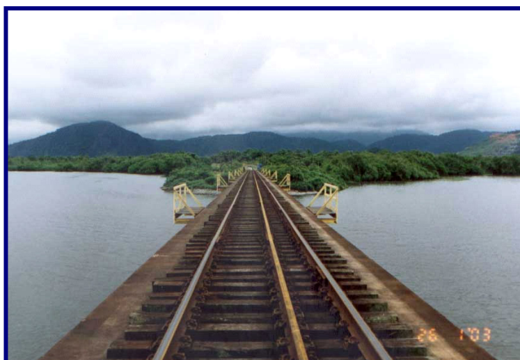
Foto 6.1- 2- Aterro de encontro da ponte ferroviária do ramal Conceiçãozinha na porção sul da área do empreendimento, com depósitos de baixios e, ao fundo, a planície de maré
