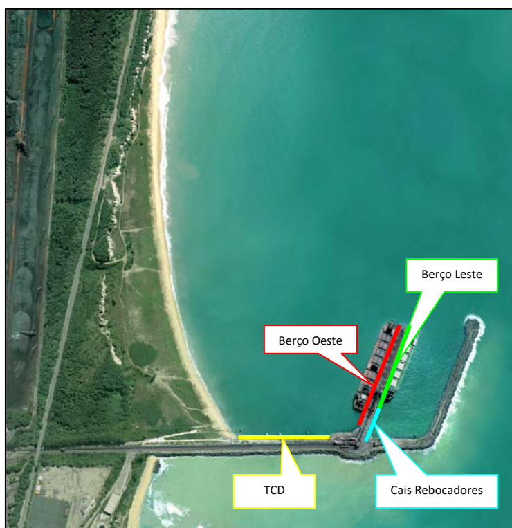
Figura 4.1-2: Vista da estrutura dos cais de atracação do Terminal Marítimo Privativo de Uso Misto da Ponta de Ubu.
