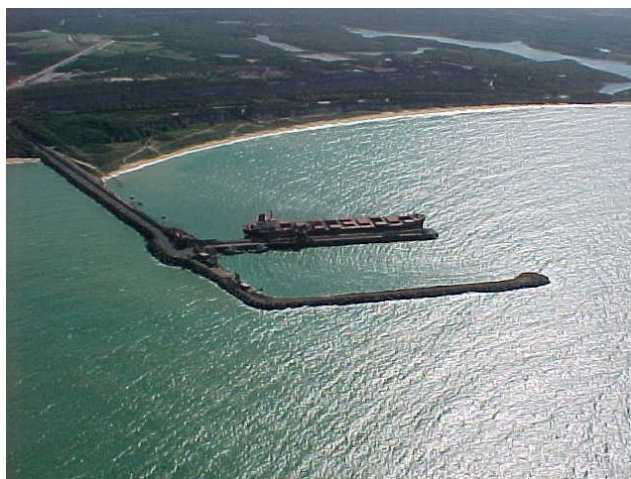
Figura 1 – Vista área do Terminal Portuário Privativo de Uso Misto de Ponta Ubu.
