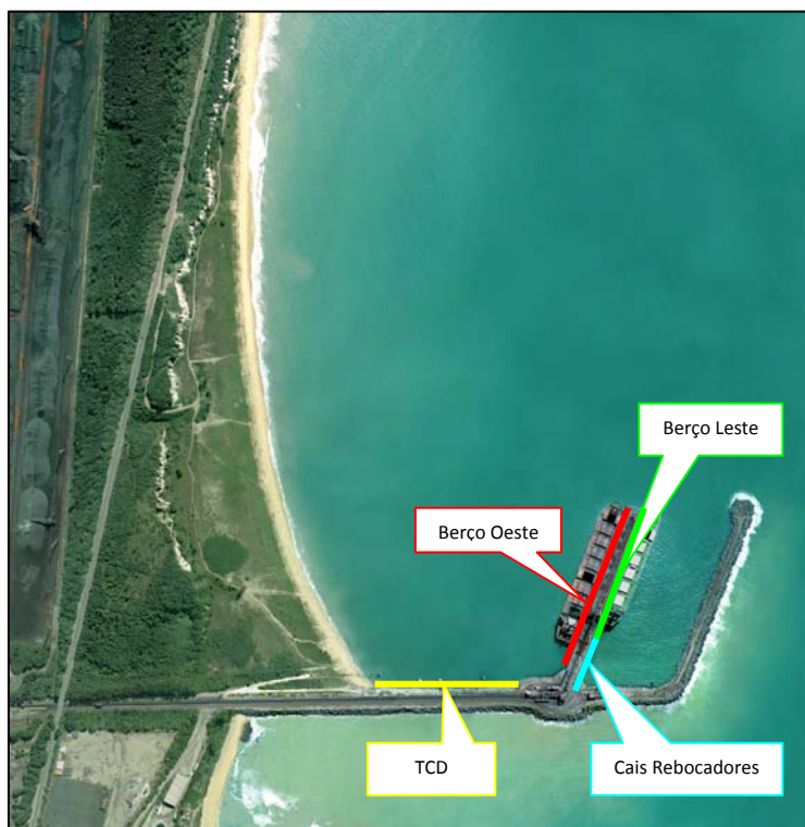
Figura 4-2: Vista da estrutura dos cais de atração do Terminal Marítimo Privativo de Uso Misto da Ponta de Ubu.
