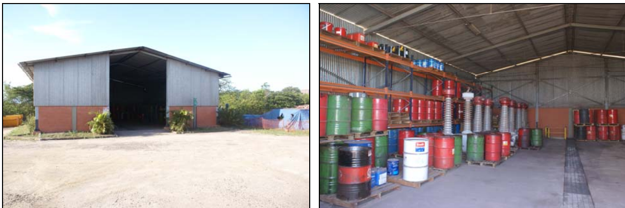
Figura II.3.5.8-1: Vista do galpão de estocagem intermediária de resíduos oleosos, localizado na Central de Gerenciamento de Resíduos da SAMARCO.
