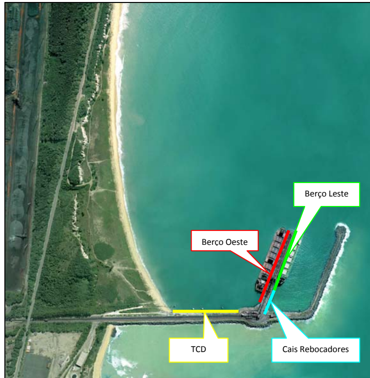
Figura I.1-2: Vista da estrutura dos cais de atração do Terminal Marítimo Privativo de Uso Misto da Ponta de Ubu.
