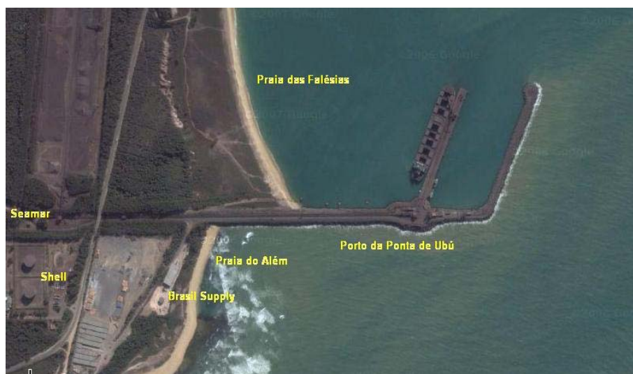
Mudar esta foto contemplando a instalação da SUBSEA7
