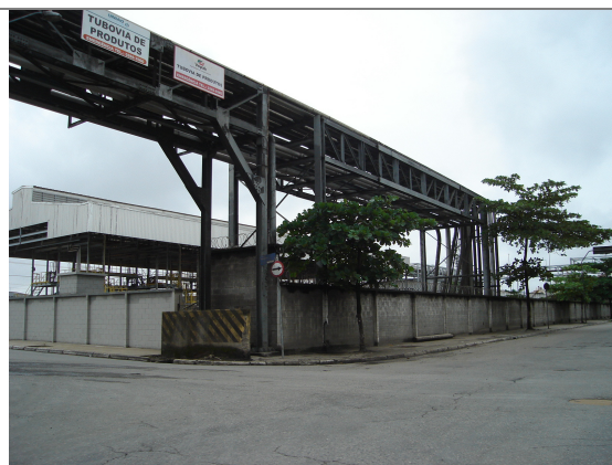
Figura 8.4.5.2 - 33: Bairro da Alemoa: cruzamentos de dutos com o sistema viário
