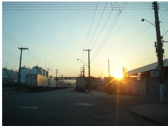
Figura 8.4.5.2 - 14: Av. Vereador Alfredo das Neves: presença constante de caminhões estacionados em ambas as laterais da via, restringindo a sua capacidade de tráfego.
