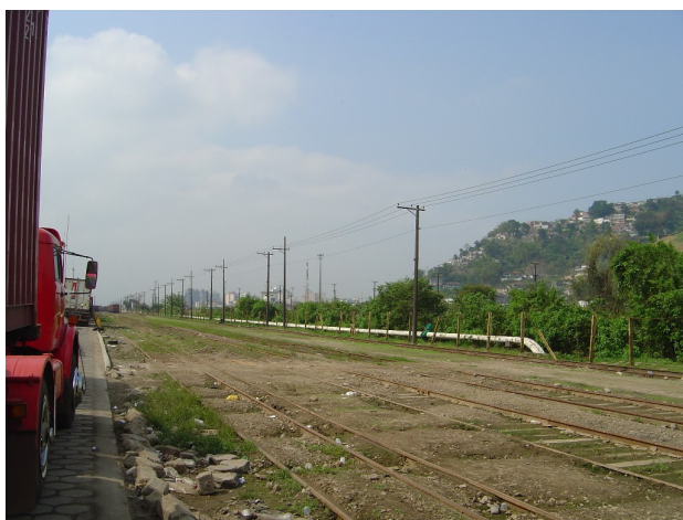
Figura 8.4.5.2 - 29: Pátio da Portofer. Antiga área da extinta Rede Ferroviária Federal.
