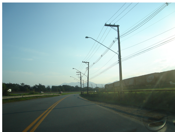
Figura 8.4.5.2 - 20: Av. Bandeirantes, ou Rodovia Caminho do Mar: trecho em que a via novamente aproxima-se da Rodovia Anchieta, já perto do bairro Casqueiro. Presença de trem de carga na ferrovia em direção ao porto de Santos.
