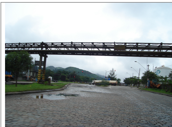
Figura 8.4.5.2 - 32: Rotatória da Alemoa: cruzamentos de dutos com o sistema viário
