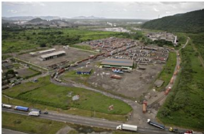
Figura 8.4.5.1.1 - 7: Vista aérea das instalações do EcoPátio.
