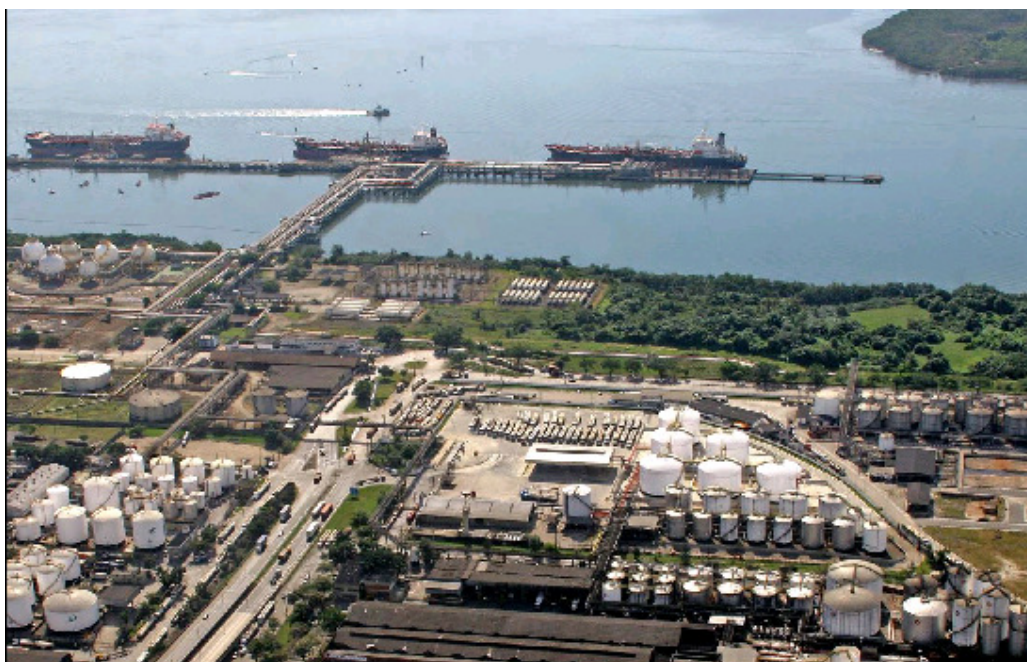
Figura 8.4.5.2 - 30: Terminal de Granéis Líquidos da Alema (TEGLA)
