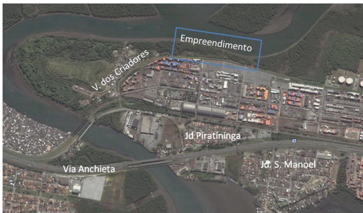
Figura 8.4.3.8 - 1: Entorno imediato da ADA do empreendimento.
