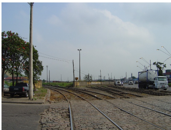
Figura 8.4.5.1.1 - 15: Final do trecho Almoa-Saboó, junto à divisa da antiga Rede Ferroviária Federal, atual pátio ferroviário da CODESP. Cruzamento em nível com ramais ferroviários
