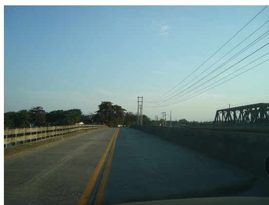
Figura 8.4.5.2 - 19: Av. Bandeirantes, ou Rodovia Caminho do Mar: travessia da ponte rodoviária com restrição de carga.
