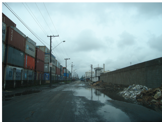
Figura 8.4.5.2 - 10: Rua Doutor Alberto Schwedtzter: trecho com pavimento ainda irregular e com depósito de resíduos sólidos em sua lateral.
