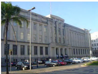
Prédio da Alfândega
