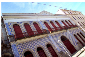
Figura 1.14.13 - 1 - Casa da Frontaria Azulejada
