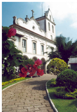
Figura 1.14.17 - 1 - Fachada da Igreja do Valongo
