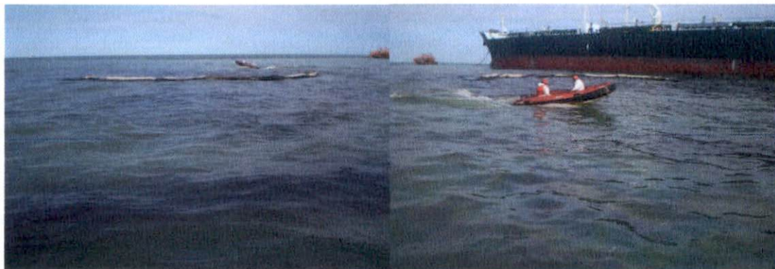
Figura 3 - CONTENÇÃO (Barreiras absorventes) (05/10/2009)
