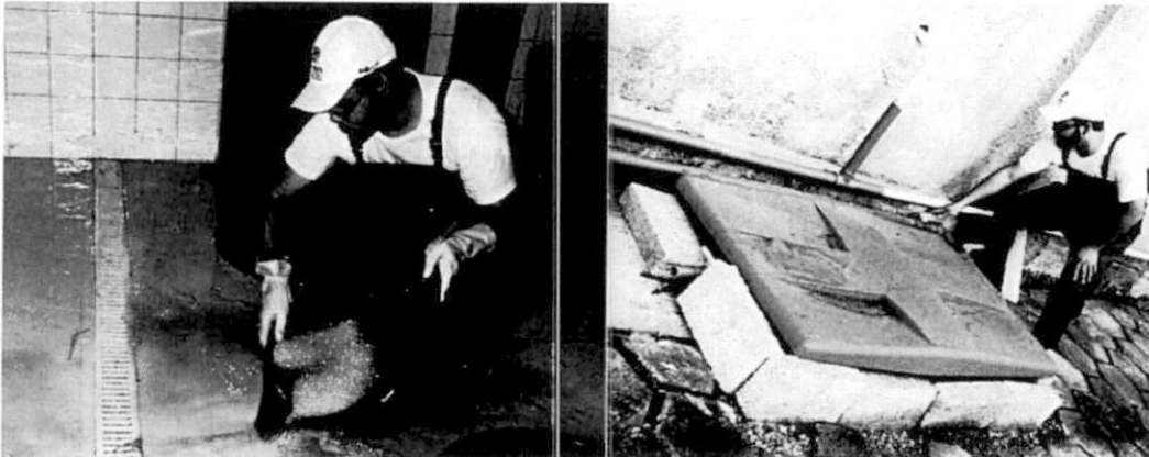
Figura 3. Destinação dos resíduos para caixa separadora de água e óleo.
