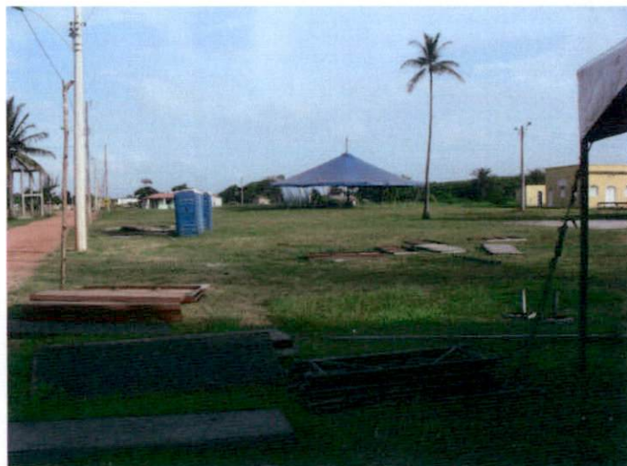
Foto 06 – Estrutura sendo montada.
