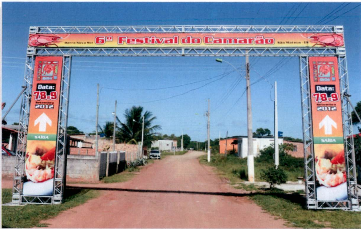
Portal montado em estrutura metálica de Q30, revestido com faixas e painéis laterais.
