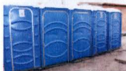
4 - BANHEIROS QUÍMICOS E LAVABOS
