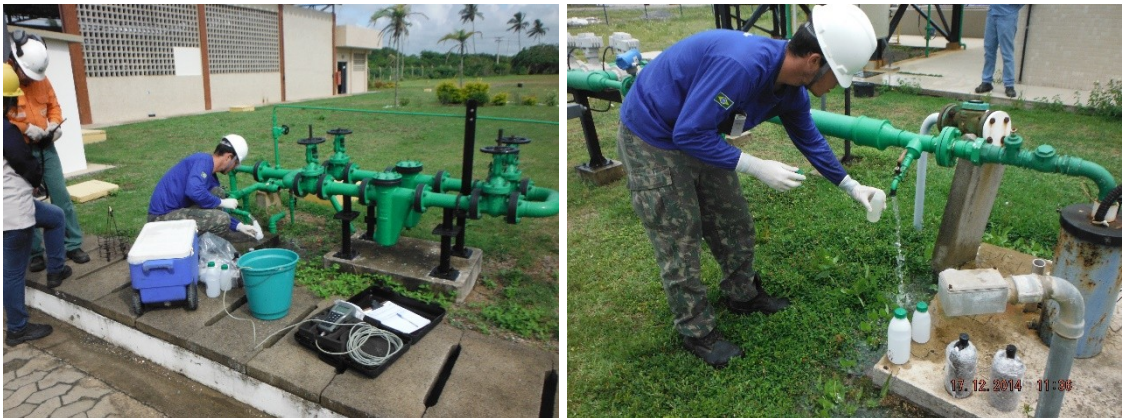
Figura 4-2: Coleta de água subterrânea nos poços Artesiano, à esquerda, e Tubular Profundo, à direita.
