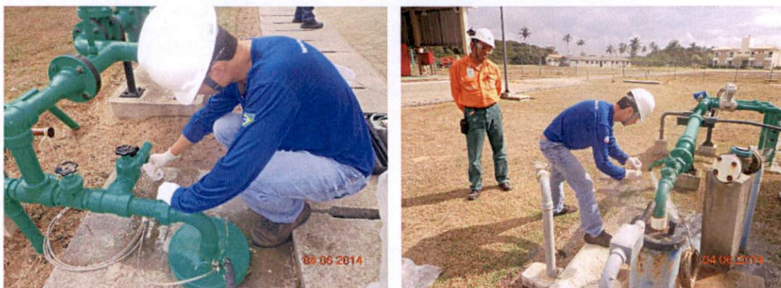
Figura 6-1: Coleta de água subterrânea nos poços Artesiano, à esquerda, e Tubular Profundo, à direita.
