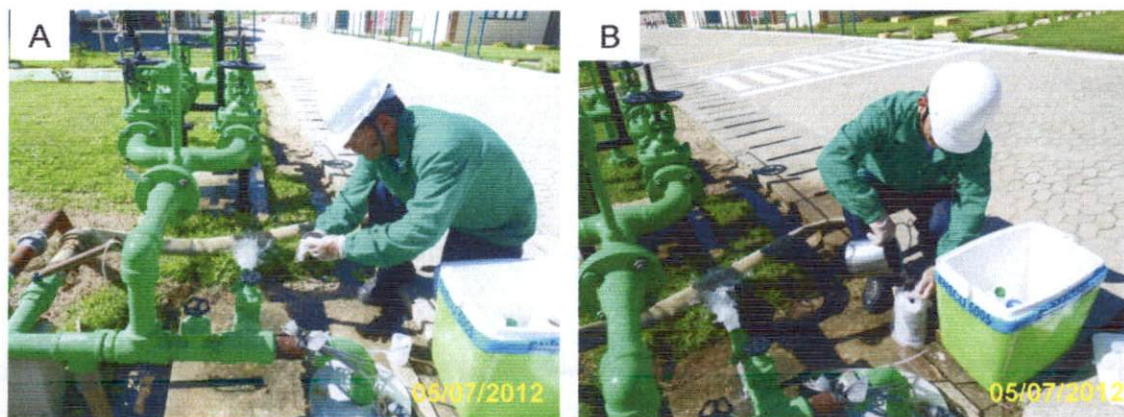
Figura 3: A e B - Coleta de água do poço tubular profundo do Terminal Norte Capixaba.
