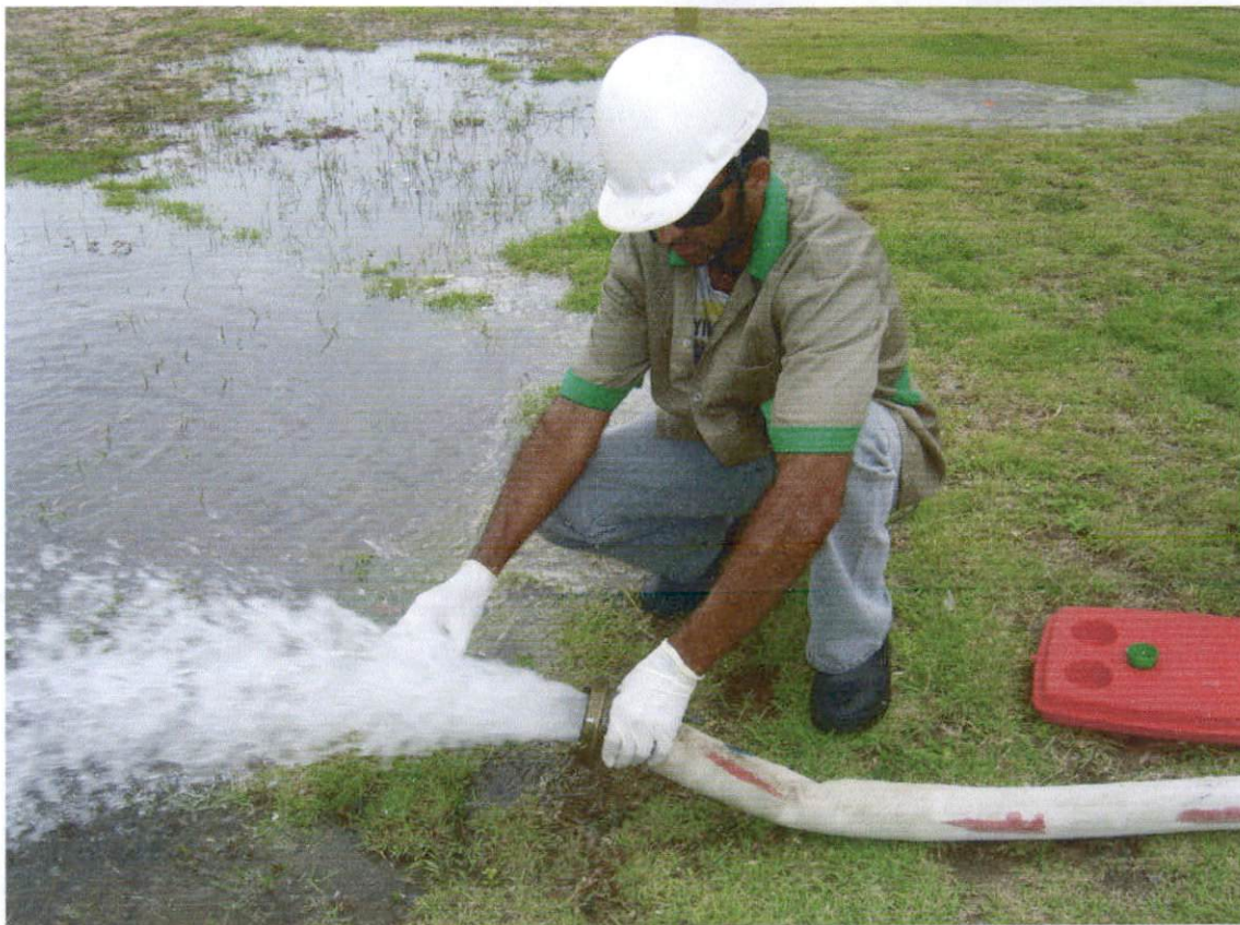
Figura 2 - Coleta de água do poço tubular profundo do TNC.
