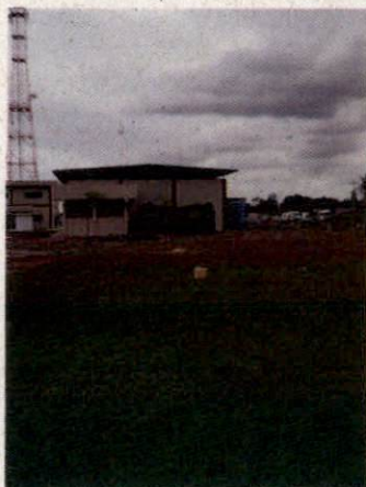
Foto 01 – Vista geral de poço de monitoramento implantado na área.
