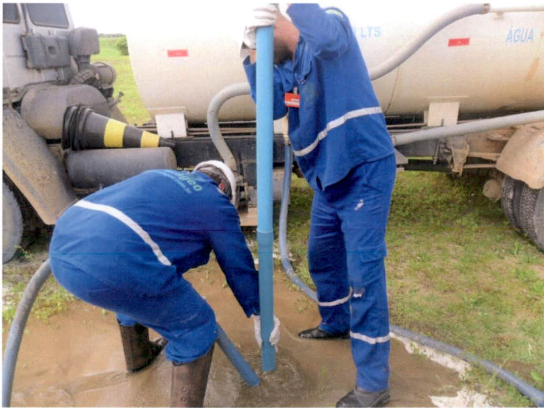
Realização de poços de monitoramento.
