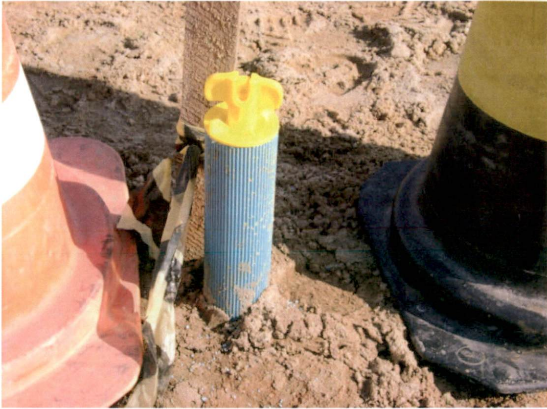
Realização de poços de monitoramento.
