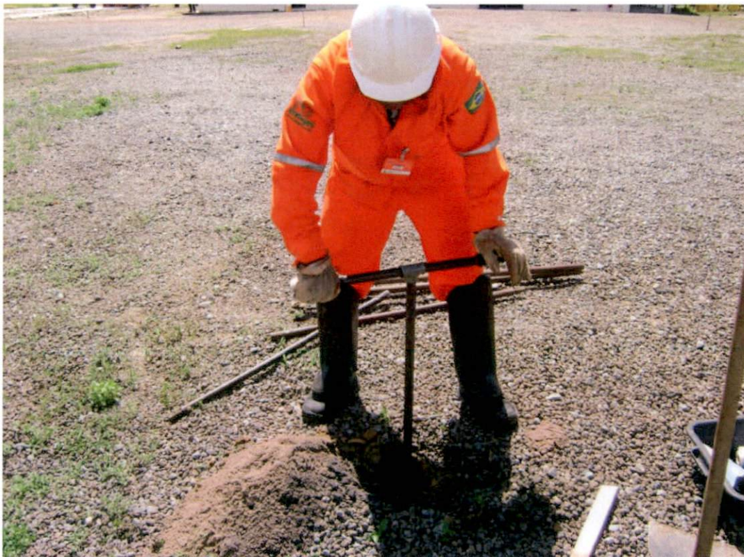
Sondagem a trado manual
