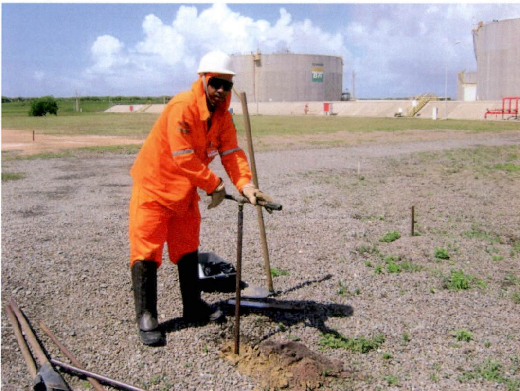
Sondagem a trado manual
