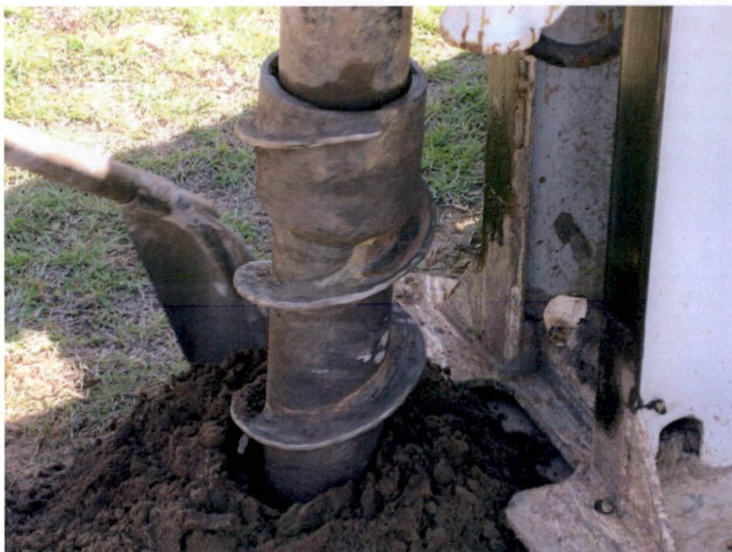
Realização de sondagens mecânicas rotativas.
