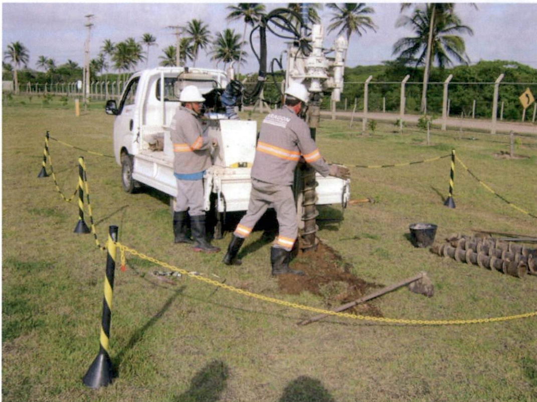
Realização de sondagens mecânicas rotativas.
