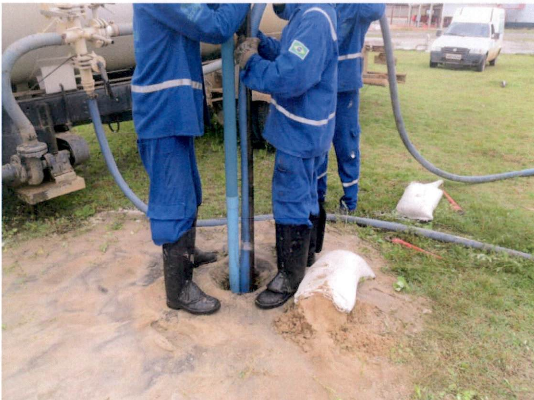
Realização de poços de monitoramento.
