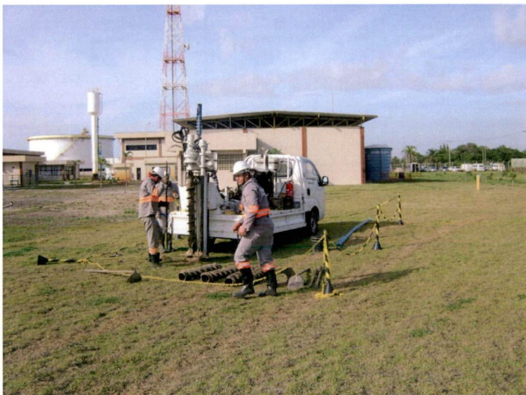
Realização de sondagens mecânicas rotativas.
