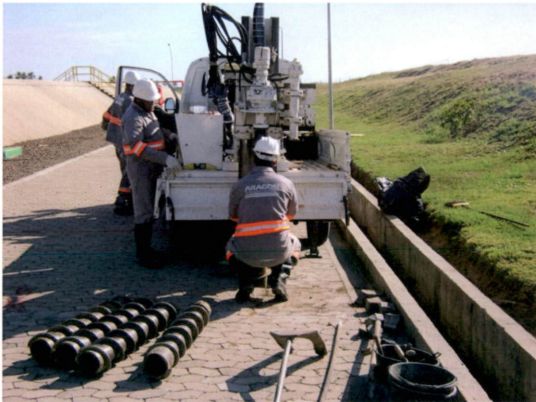
Realização de sondagens mecânicas rotativas.
