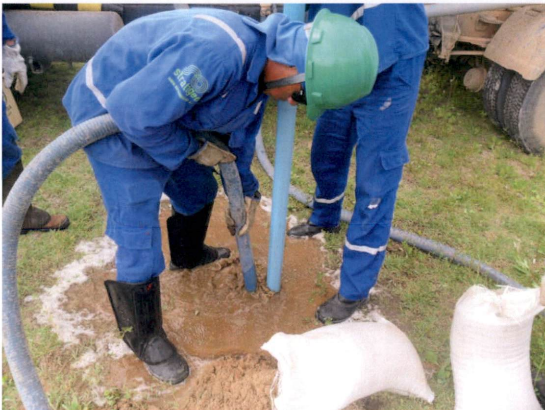
Realização de poços de monitoramento.
