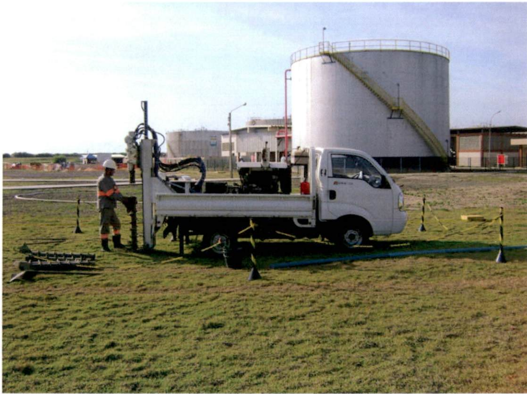
Realização de sondagens mecânicas rotativas.
