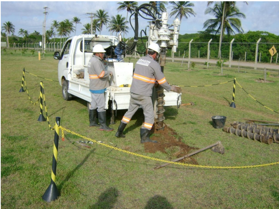
Realização de sondagens mecânicas rotativas.
