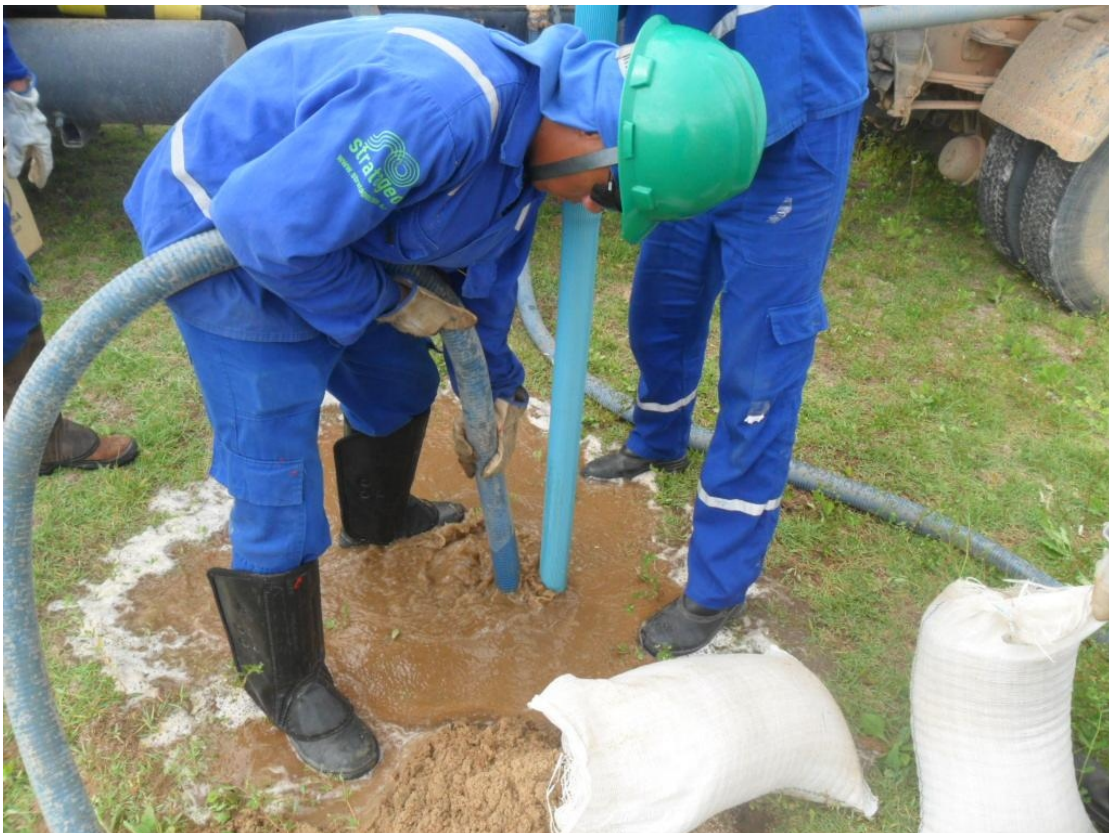
Realização de poços de monitoramento.
