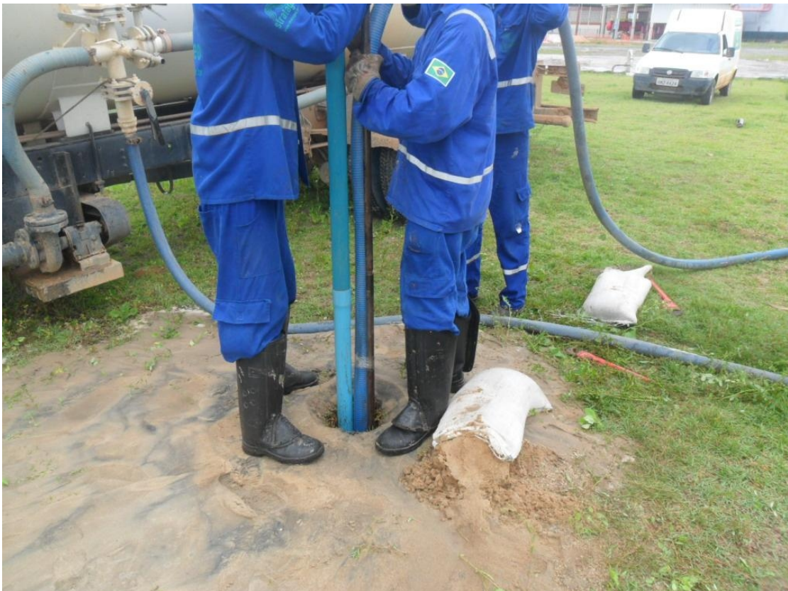
Realização de poços de monitoramento.
