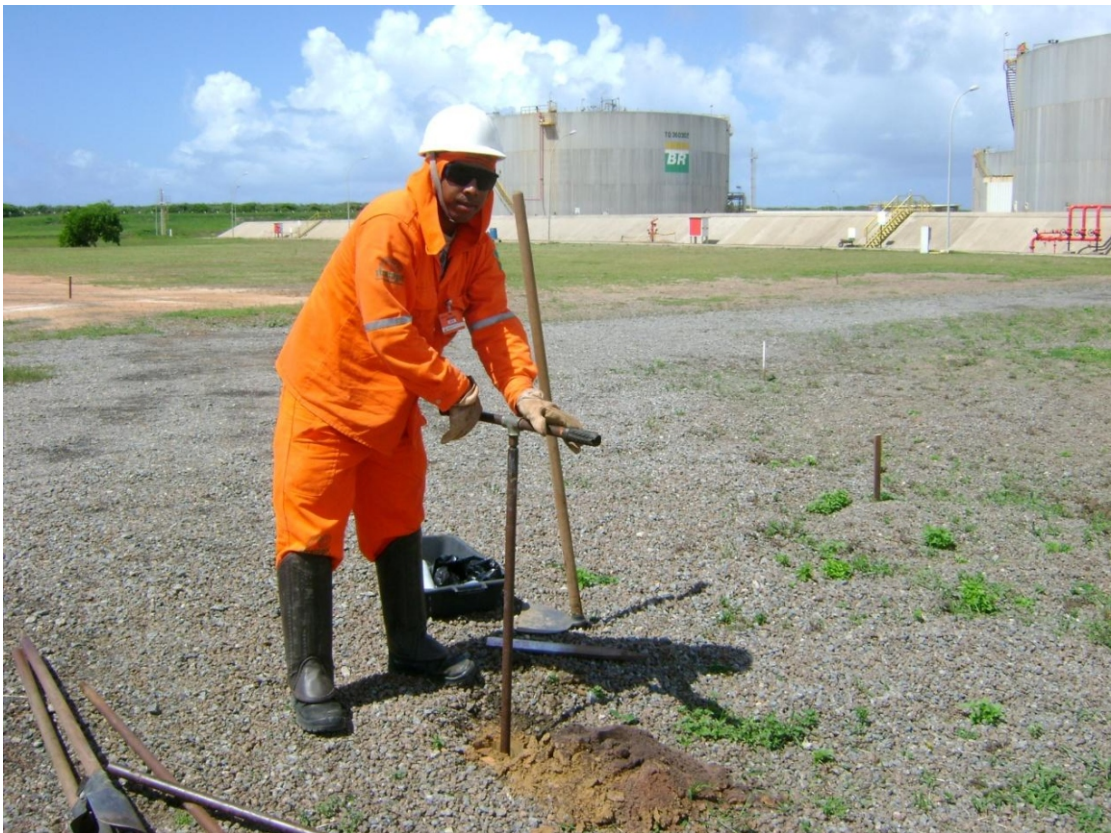
Sondagem a trado manual
