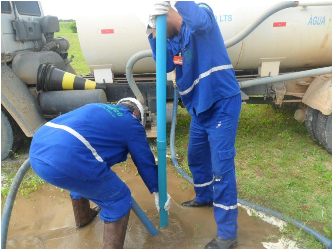
Realização de poços de monitoramento.
