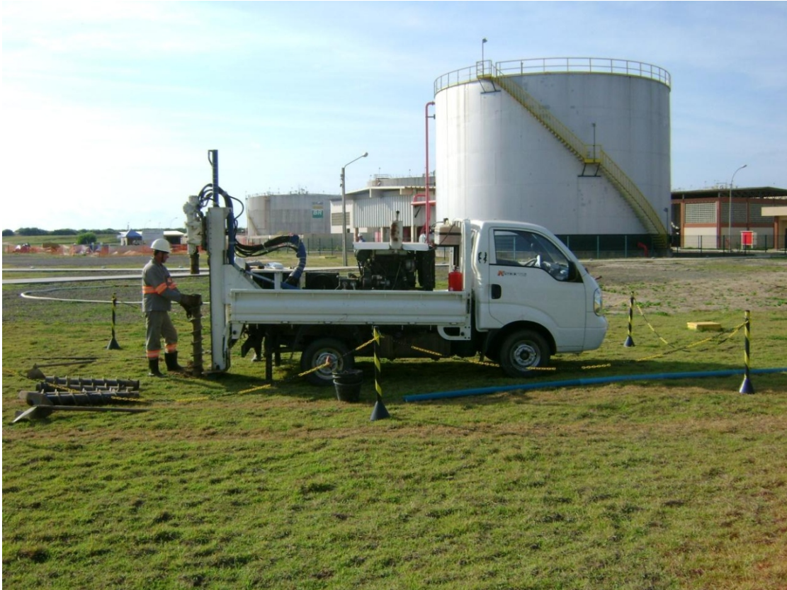
Realização de sondagens mecânicas rotativas.
