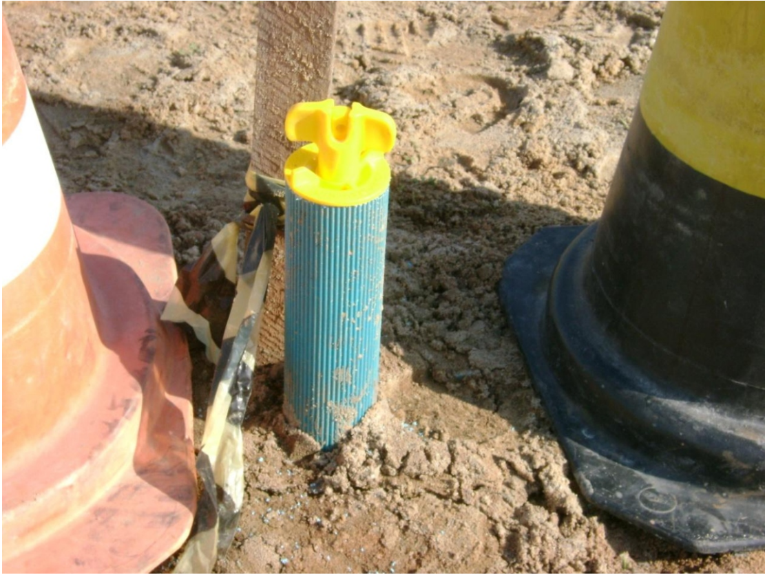
Realização de poços de monitoramento.
