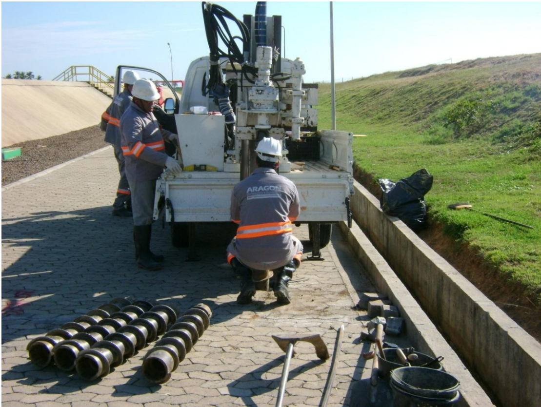
Realização de sondagens mecânicas rotativas.
