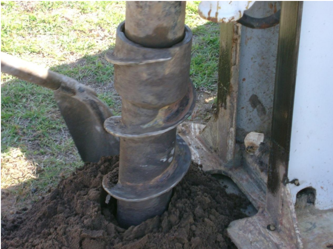
Realização de sondagens mecânicas rotativas.
