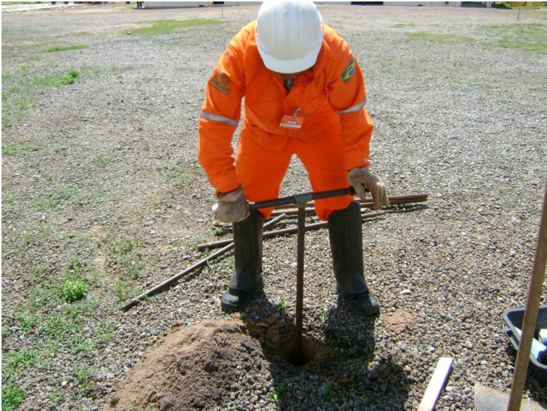
Sondagem a trado manual
