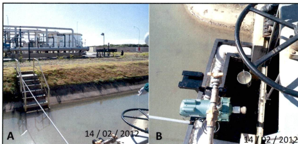
Figura II.2.1-3 – Coleta de águas pluviais no ponto PM03 (A) e sistema de drenagem do TNC (B) – Campanha de Fevereiro/2012.
