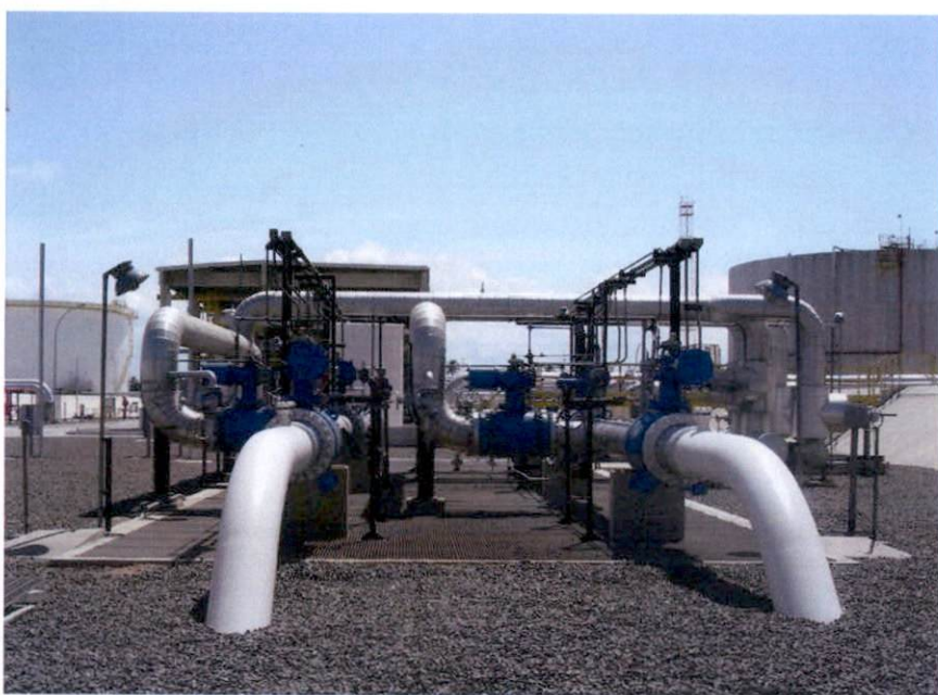
Figura 07 – Scrapper de saída e início do oleoduto submarino
