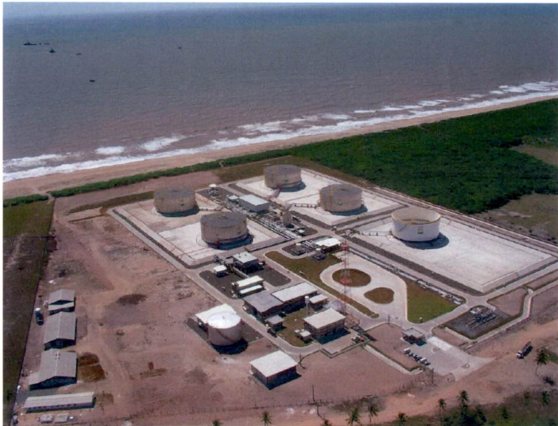
Figura 01 – Vista aérea do Terminal Norte Capixaba
