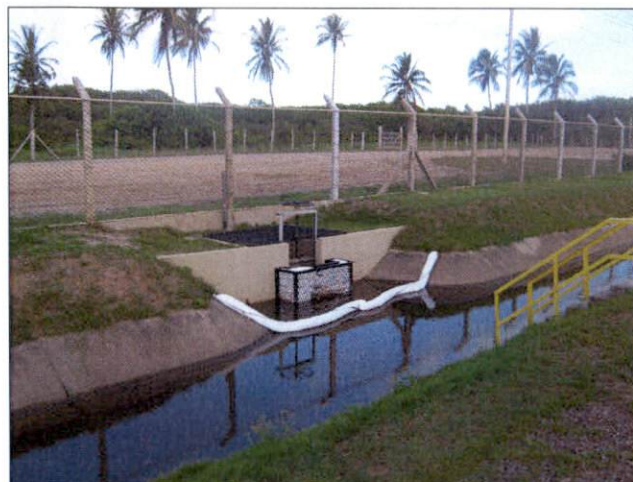
BARREIRAS DE CONTENÇÃO PRÓXIMAS A COMPORTA DA REDE PLUVIAL
