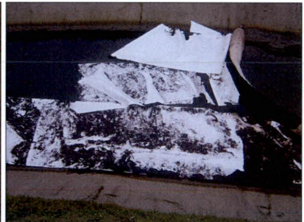
LIMPEZA DAS CANALETAS PLUVIAIS (MANTAS ABSORVENTES)
