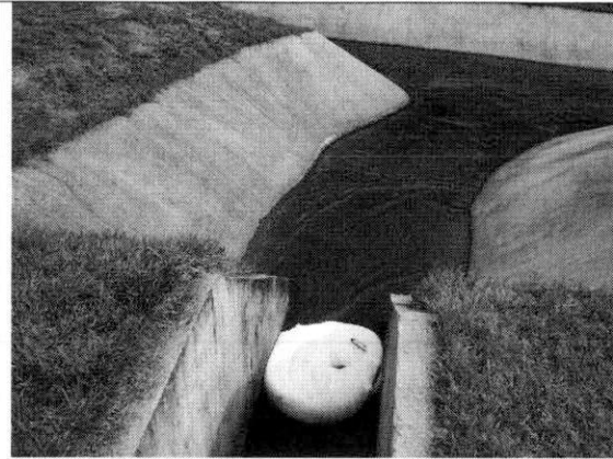
Foto 08– Bóias de contenção colocadas dentro do canal.
