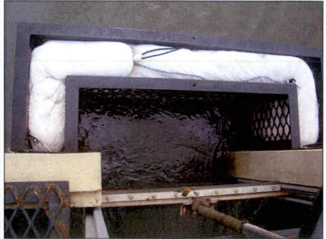
COMPORTA DA REDE PLUVIAL FECHADA E COM BARREIRAS ABSORVENTES
