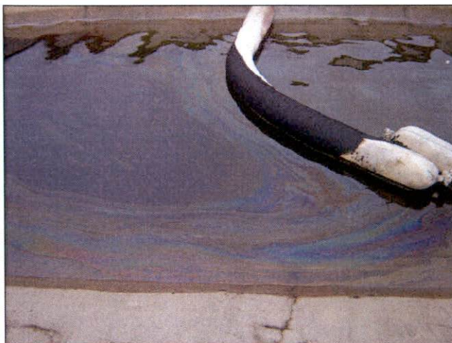
CANALETAS PLUVIAIS COM ÓLEO E BARREIRAS DE CONTENÇÃO
