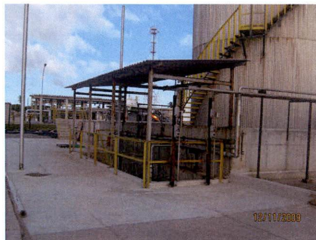
ÁREA PRÓXIMA AO TANQUE 360308
