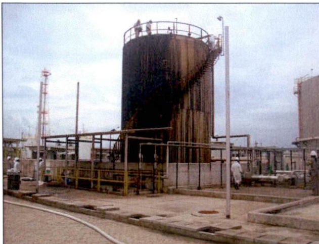
EQUIPE DE LIMPEZA FAZENDO LIMPEZA DO COSTADO DO TANQUE
