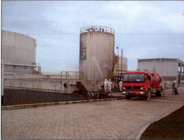
LIMPEZA DO COSTADO DO TANQUE DEPOIS DA 1ª LIMPEZA
