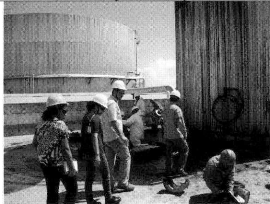
Foto 18- Equipe do licenciamento realizando a vistoria.
