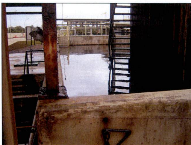
DIQUE DE CONTENÇÃO DO TANQUE 360308 E DA ÁREA DA CXP (CAIXA DE SEPARAÇÃO DE ÁGUA E ÓLEO)
