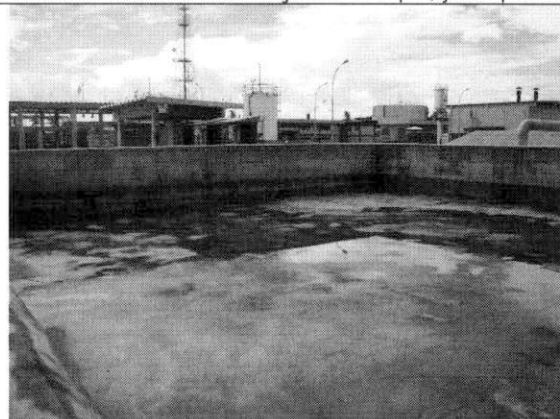
Foto 12- Área de contenção do tanque, já limpa.
