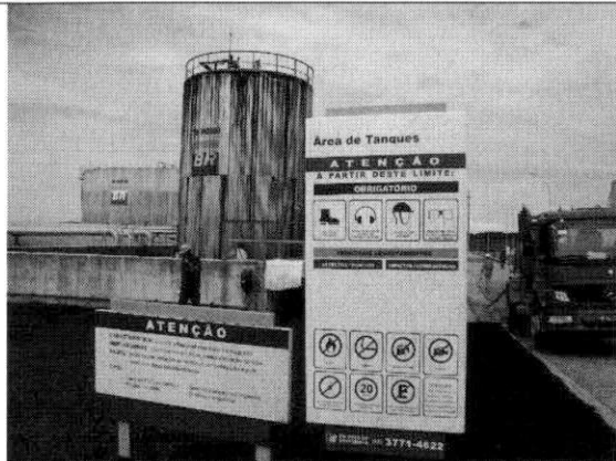
Foto - 03 - Placas sinalizadoras.
