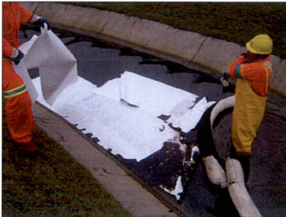
LIMPEZA DAS CANALETAS PLUVIAIS (MANTAS ABSORVENTES)
