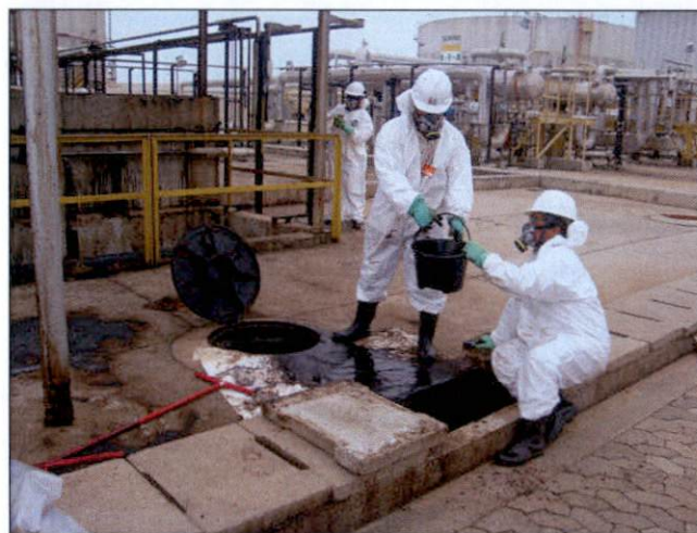
LIMPEZA DAS CANALETAS PRÓXIMAS À ÁREA DO TANQUE 360308
