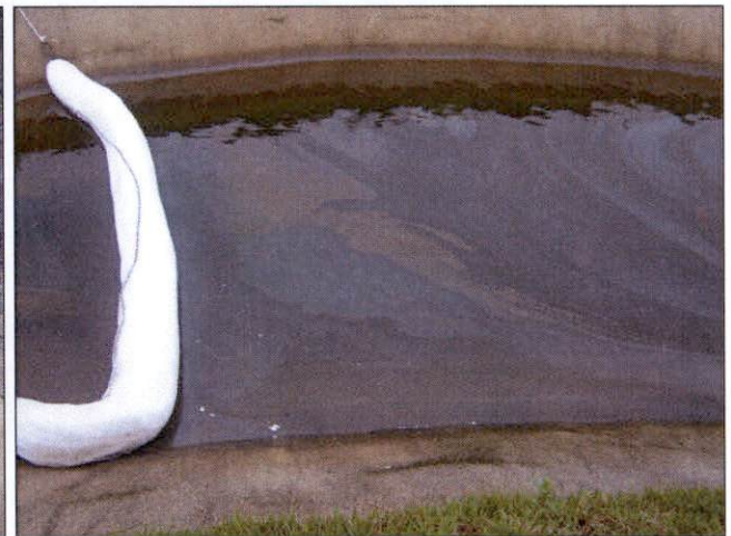
CANALETAS PLUVIAIS COM ÓLEO E BARREIRAS DE CONTENÇÃO
