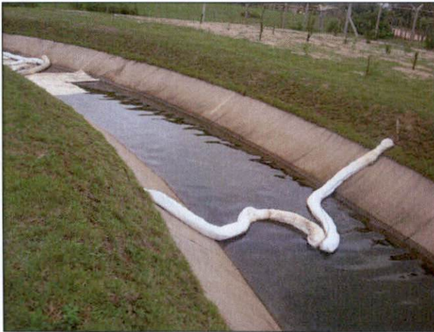
LIMPEZA DAS CANALETAS E DAS ÁREAS PRÓXIMAS AO TANQUE 360308
