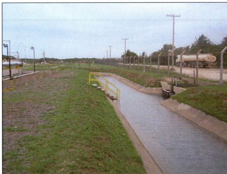
CANALETAS PLUVIAIS APÓS LIMPEZA
