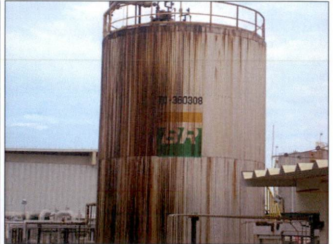
LIMPEZA DO COSTADO DO TANQUE DEPOIS DA 1ª LIMPEZA
