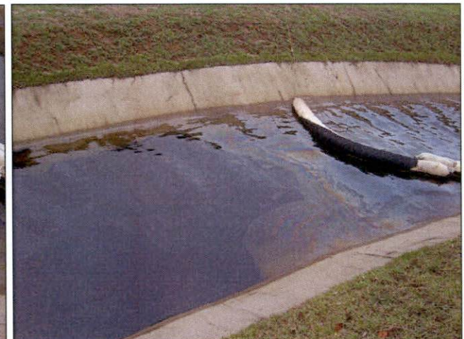
CANALETAS PLUVIAIS COM ÓLEO E BARREIRAS DE CONTENÇÃO
