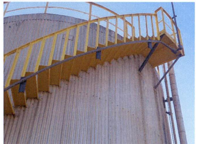
TANQUE APÓS LIMPEZA DO COSTADO
