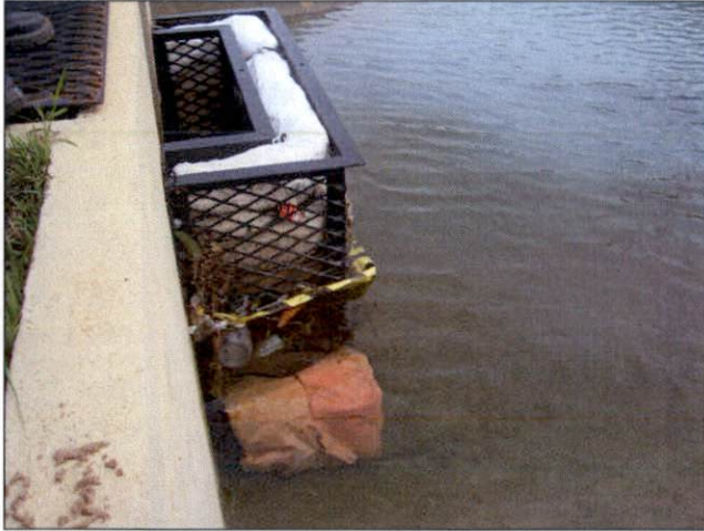
COMPORTA DA REDE PLUVIAL FECHADA E COM BARREIRAS ABSORVENTES
