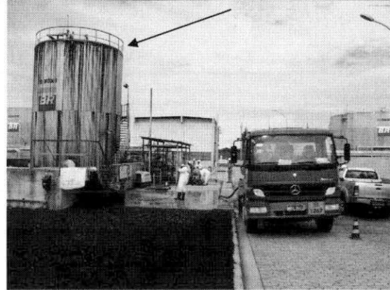
Foto 02- Vista da Mancha de óleo por onde aconteceu o transbordamento.
