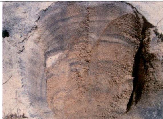
Foto-47- Cavas para identificação de substâncias oleosas, cavas estas realizadas na boca da lagoa.
