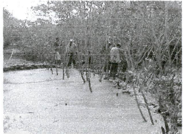
Foto 04: Área do acidente.
