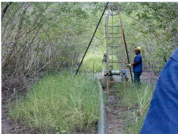
Fig 01 – Tripé montado para execução da sondagem da segunda campanha
