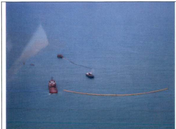
Foto - 33 - Procedimento para substituição do sistema da bóia danificada, com a instalação de bóias de contenção.
