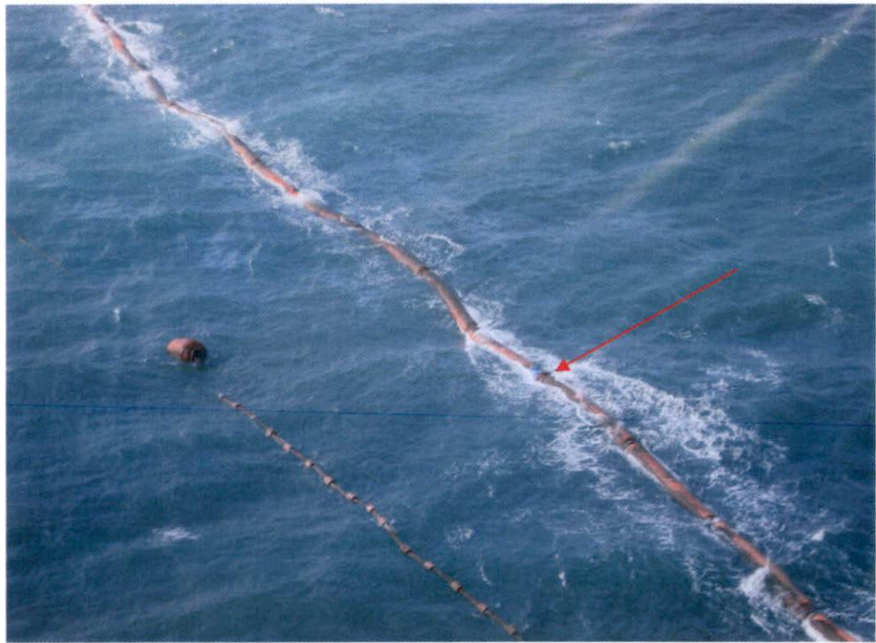
Foto 30- Ponto onde houve o rompimento e o vazamento do petróleo.
