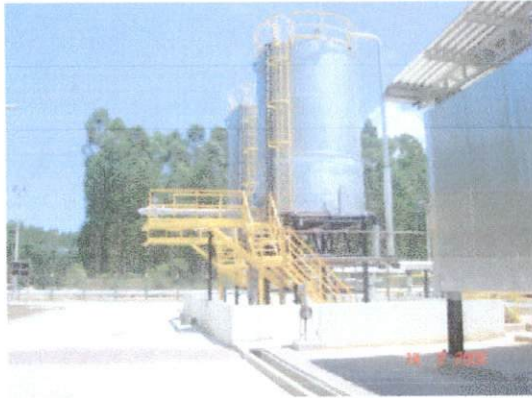
Ponto de coleta FAL 40 – bacia de contenção implantada e impermeabilização da área de estacionamento de veículo.
