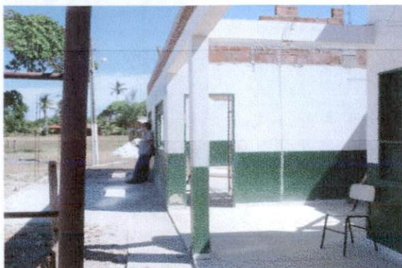
Fig. 1 – Escola em reforma pela Transpetro
