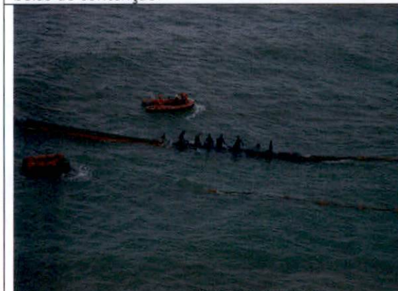
Foto - 35 - Mergulhadores realizando o encapsulamento da bóia, estancando o vazamento.
