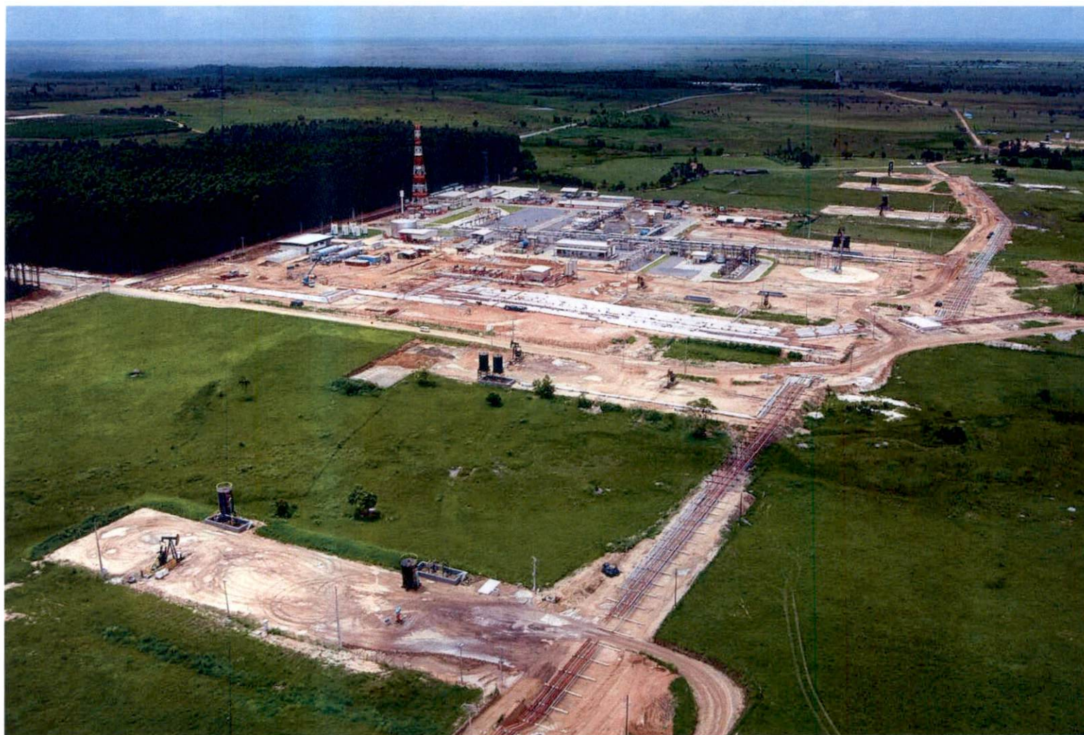
Foto 02: Vista geral do Ponto de Coleta FAL-20 – Detalhe: para a Travessia N° 08 entre os poços FAL-22/FAL-08.
