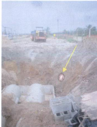
Fig.05- Caixa receptora da drenagem pluvial final do TNC em fase de construção
