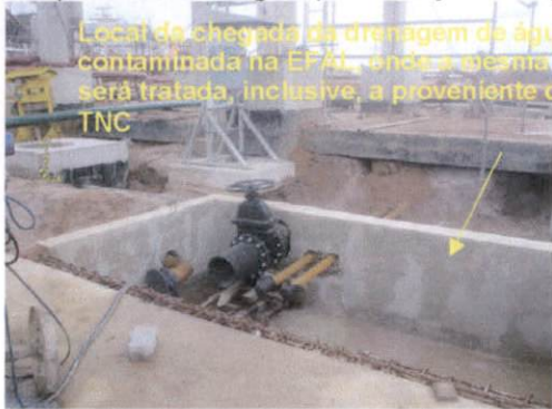
Fig.03 e 04- Sistema de drenagem de água contaminada (óleo) em fase de finalização. Tanque de armazenamento de água que será utilizada para rejeição em poços de perfuração, não havendo descarte da mesma no meio ambiente.
