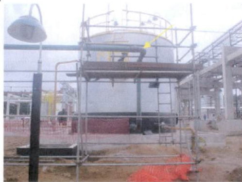
Fig.03 e 04- Sistema de drenagem de água contaminada (óleo) em fase de finalização. Tanque de armazenamento de água que será utilizada para rejeição em poços de perfuração, não havendo descarte da mesma no meio ambiente.
