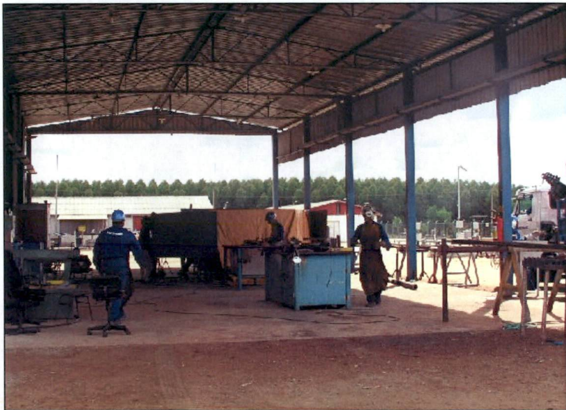
Foto 12 – Detalhes das instalações.
