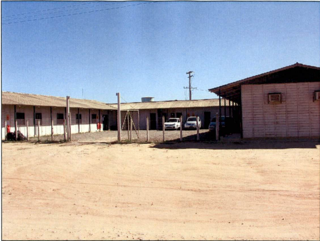
Foto 15 – Vista geral do galpão da ISUP.
