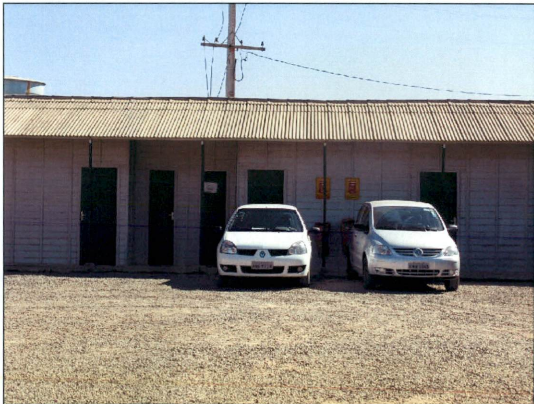
Foto 16 – Área de estacionamento, banheiros e escritório.
