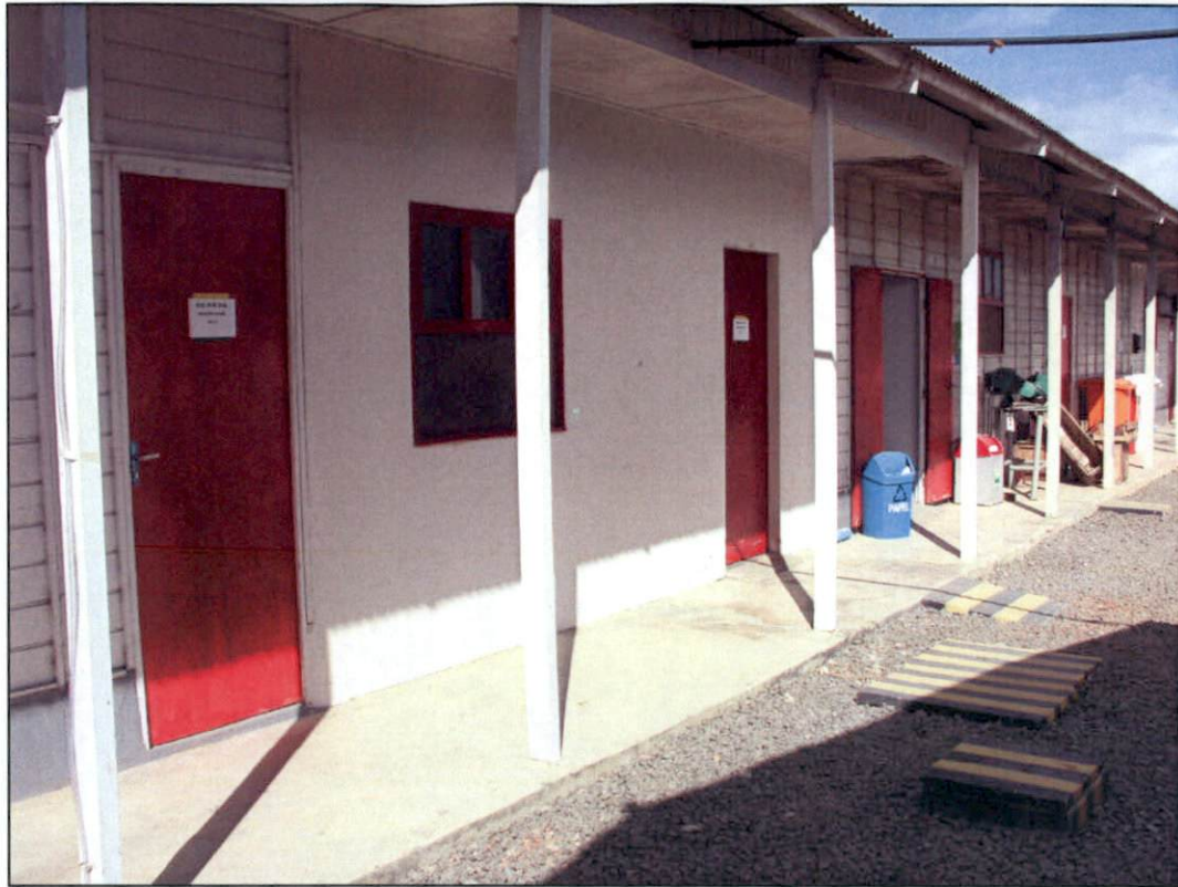
Foto 05 – Vista lateral do galpão.
