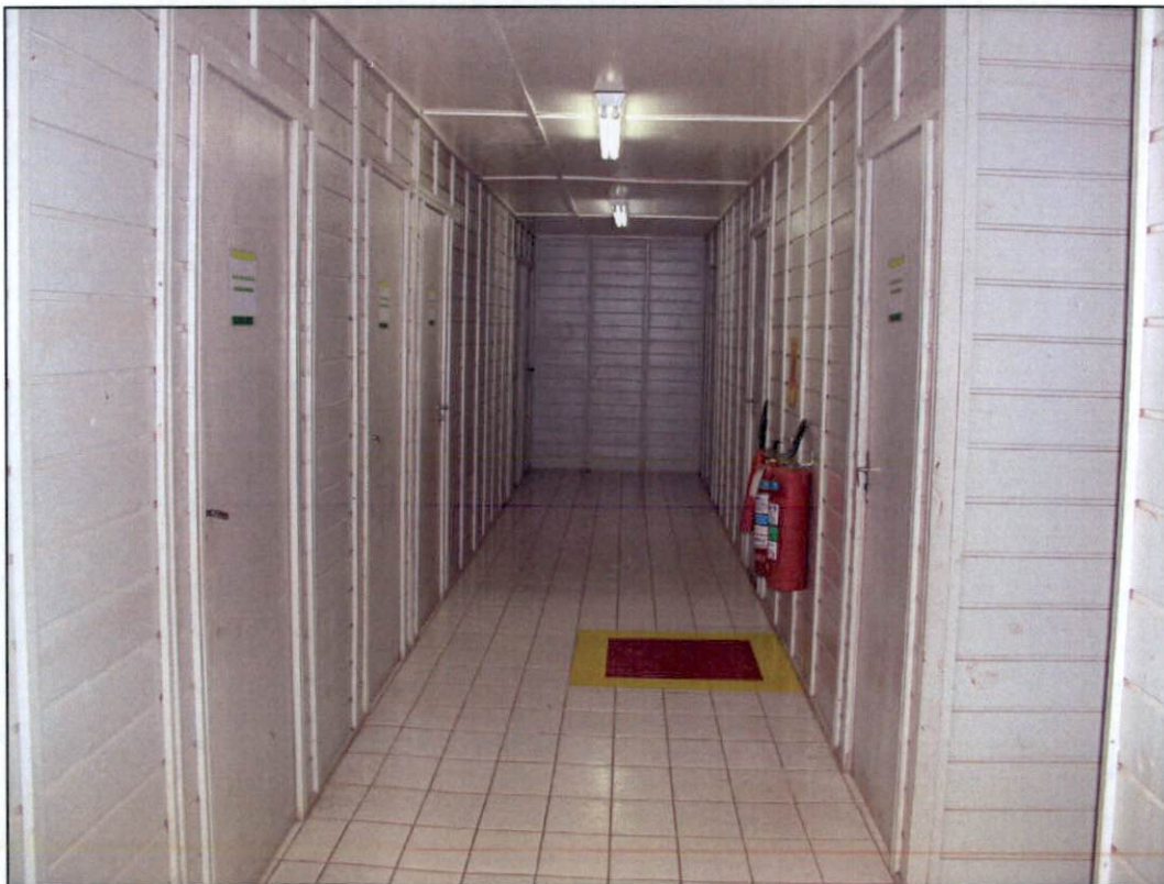
Foto 02 – Corredor interno do galpão administrativo.
