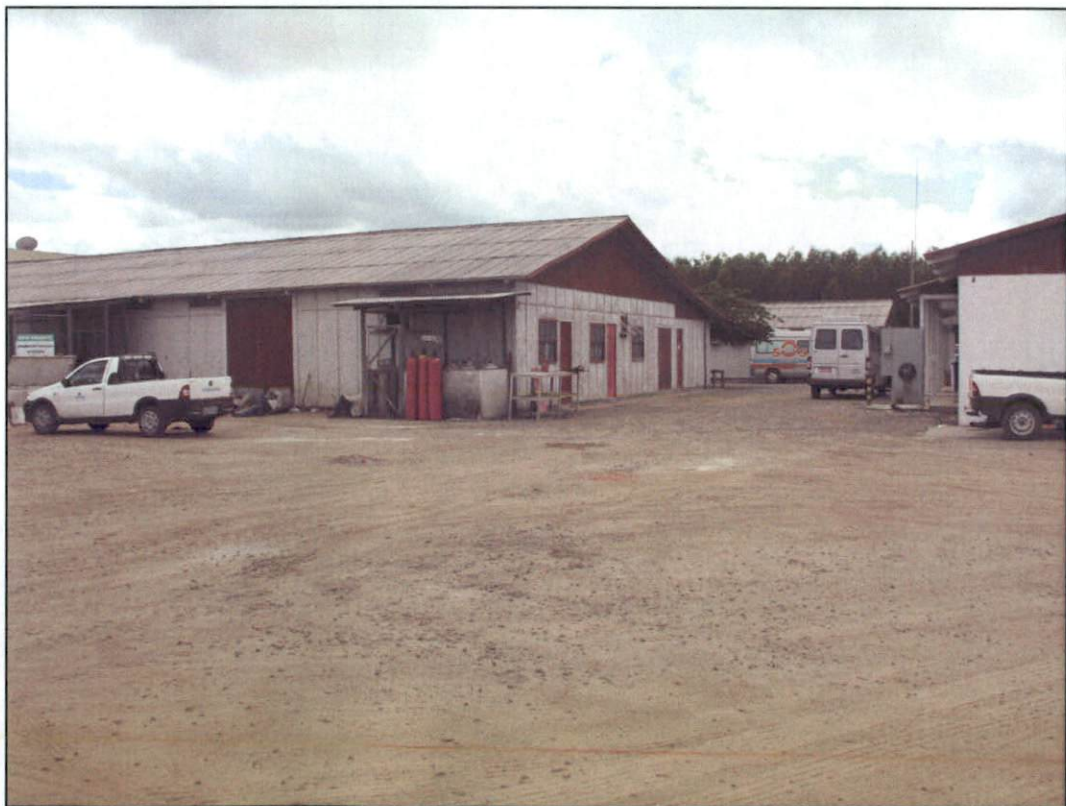
Foto 10 – Vista geral do galpão depósito geral.
