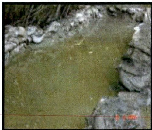
FOTOS 17 e 18: COMO MEDIDA DE SEGURANÇA MANTIVERAM-SE AS BACIAS DE CONTENÇÃO ATÉ O FINAL DO FURO , AO MESMO TEMPO EM QUE SE ESPERAVA QUE O RESIDUO FINAL DECANTASSE PARA SUA POSTERIOR REMOÇÃO MANUAL . DE 13 a 22.08.05 .
