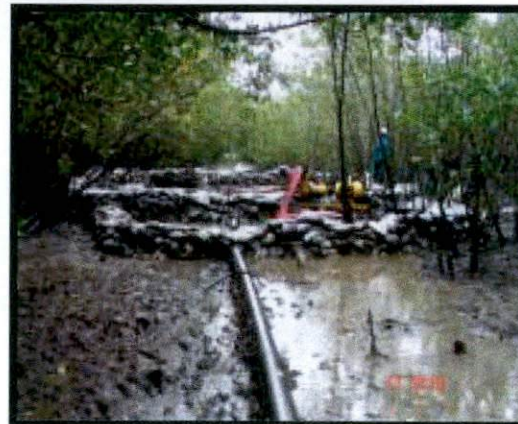
FOTO 10 : VISTA GERAL DAS BACIAS DE CONTENÇÃO (2) PRONTAS EM 09.08.05
