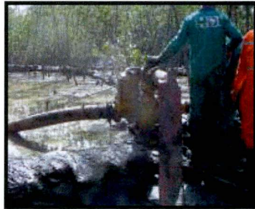
FOTO 14 : EM FUNÇÃO DE PROBLEMAS NA INSTALAÇÃO DA BOMBA ESTA FICOU PRONTA EM 12.08.05
