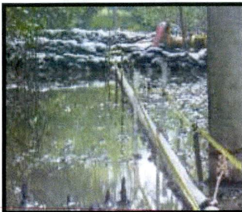
FOTO 29: SINALIZAÇÃO DE SEGURANÇA INSTALADA NO TUBO PAD PELO SMS-HDI EM 10.08.05
