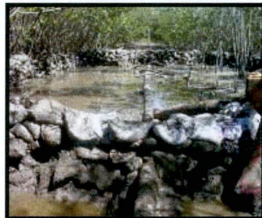
FOTO16: FINAL DO BOMBEAMENTO DA LAMA EM 13.08.05
