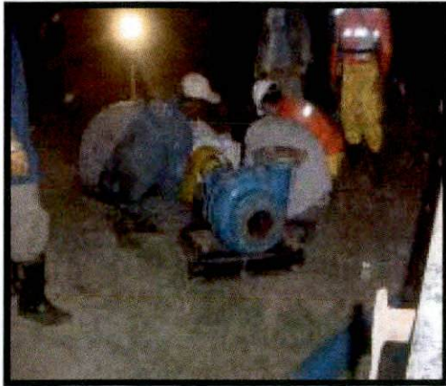
FOTO 13: INSTALAÇÃO DA BOMBA PARA BOMEIO DO MATERIAL (LAMA DE BENTONITA) EM 10.08.05
