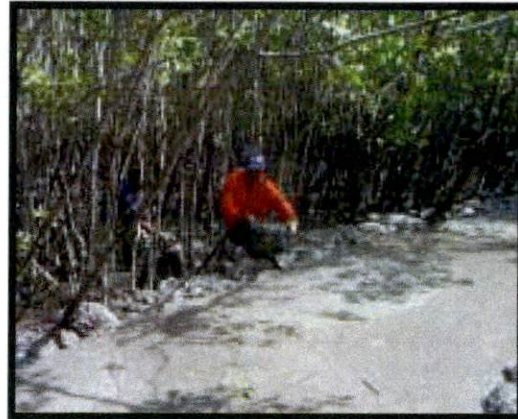
FOTO 8 : INICIO DA CONSTRUÇÃO DAS BACIAS ( 2) DE CONTENÇÃO EM 08.08.05
