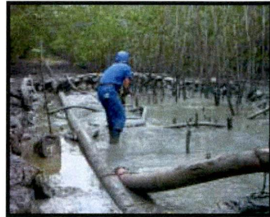
FOTO 20 : INICIO DOS TRABALHOS MANUAIS DE REMOÇÃO DA LAMA (22.08.05)
