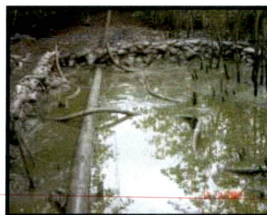
FOTOS 17 e 18: COMO MEDIDA DE SEGURANÇA MANTIVERAM-SE AS BACIAS DE CONTENÇÃO ATÉ O FINAL DO FURO , AO MESMO TEMPO EM QUE SE ESPERAVA QUE O RESIDUO FINAL DECANTASSE PARA SUA POSTERIOR REMOÇÃO MANUAL . DE 13 a 22.08.05 .
