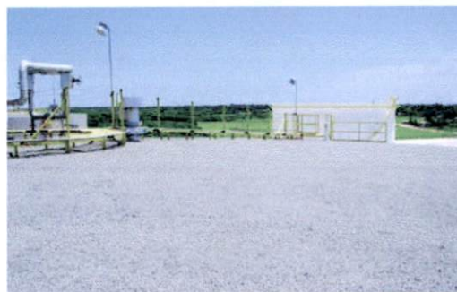
Teto do tanque de petróleo pesado
