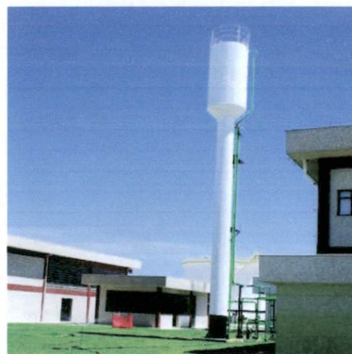
Castelo de água
