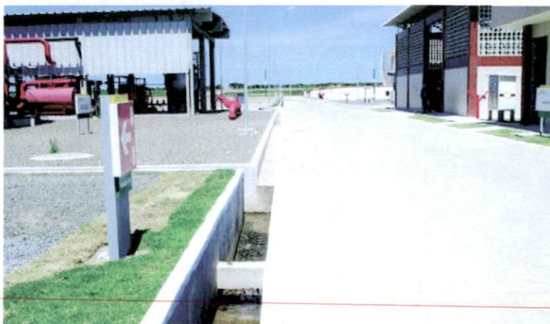
Canaleta de drenagem pluvial
